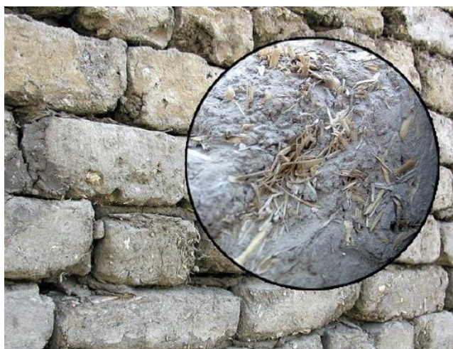
Figura 2.1 – Muro com tijolo reforçado com palha no Egito (CÁNOVAS, 1997).
