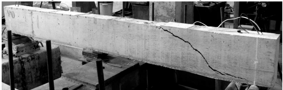
e) Viga após o ensaio ( V_u = 125,5 kN)
