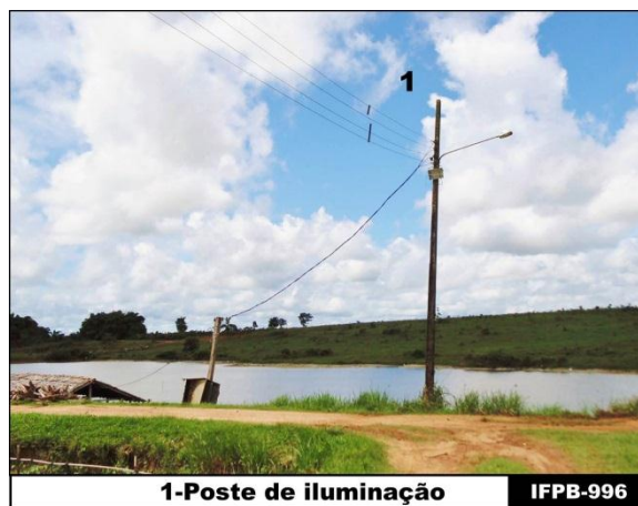
1-Poste de iluminação
