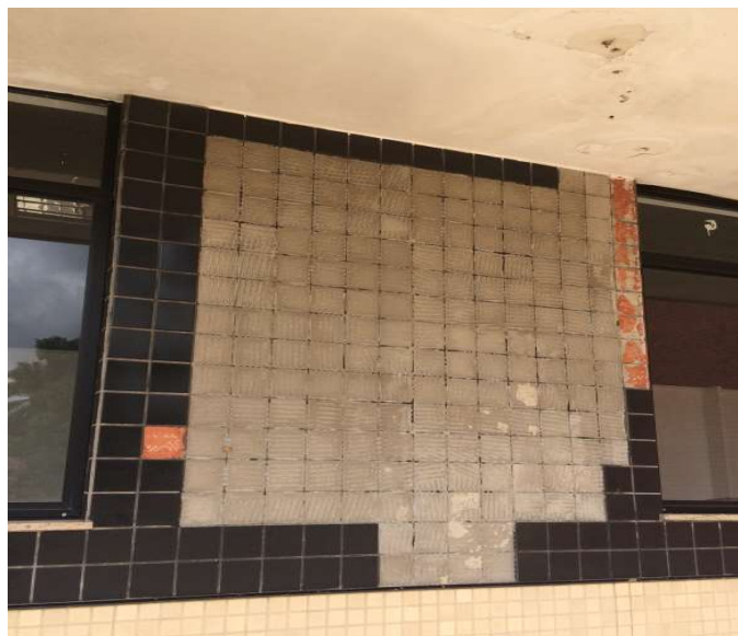
Figura 2.15 – Deslocamento do revestimento (Autor, 2017).
