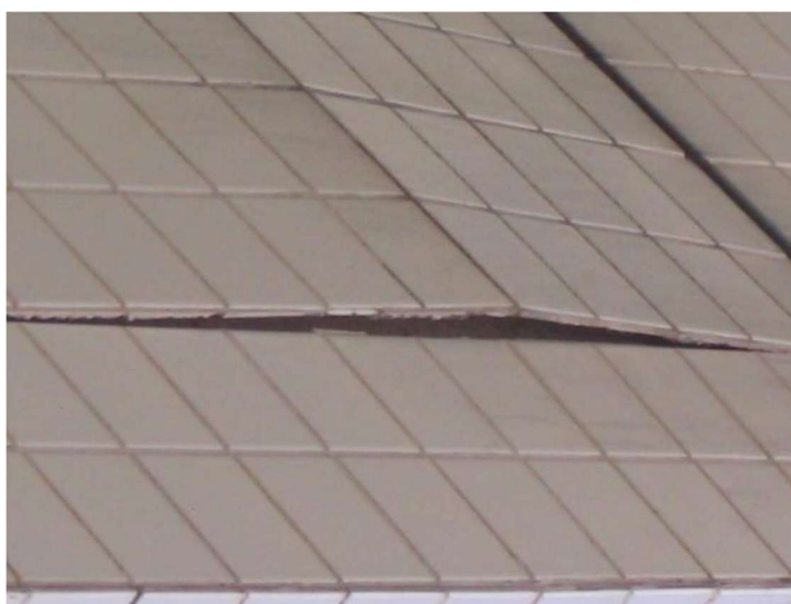
Figura 2.14 – Descolamento de placas cerâmicas (Silva, 2014).
