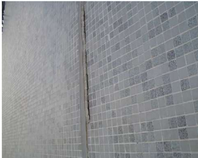
Figura 2.17 – Falha na junta de assentamento da placa cerâmica (Autor, 2017).
