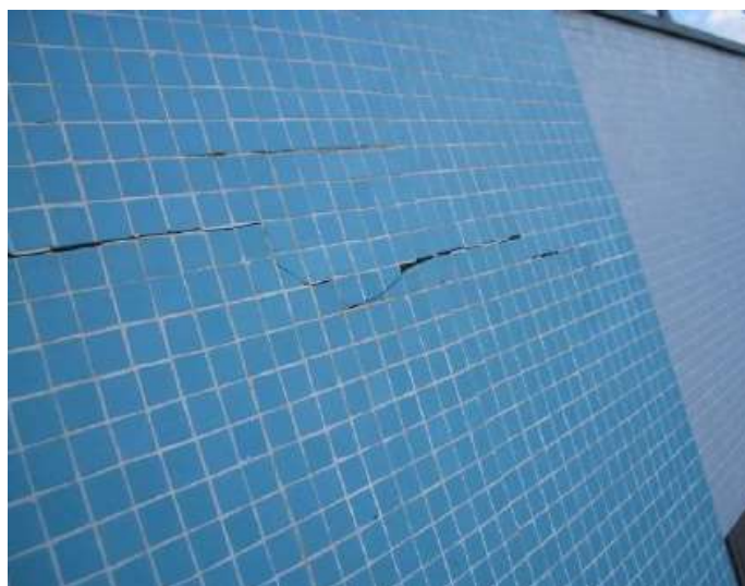
Figura 2.16 – Fissuras em revestimento cerâmico (Silva, 2014).
