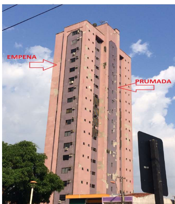
Figura 3.2 – Identificação da prumada e empena em uma amostra de fachada.
