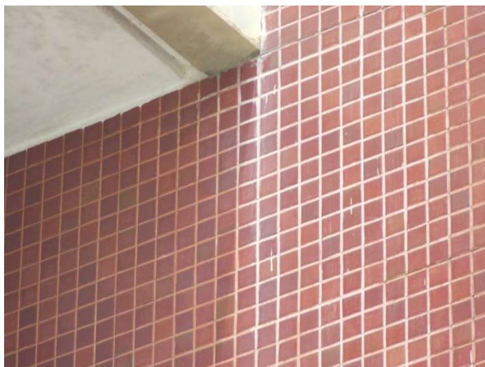
Figura 2.19 – Local na fachada com eflorescência (Autor, 2017).
