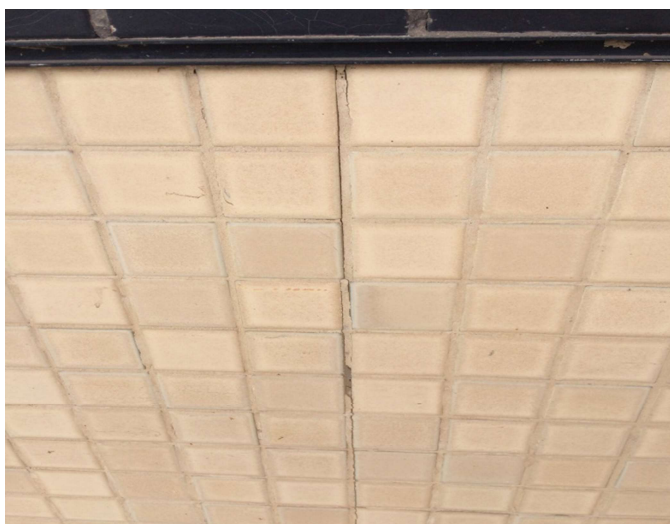
Figura 2.18 – Deterioração da argamassa de rejunte (Autor, 2017).
