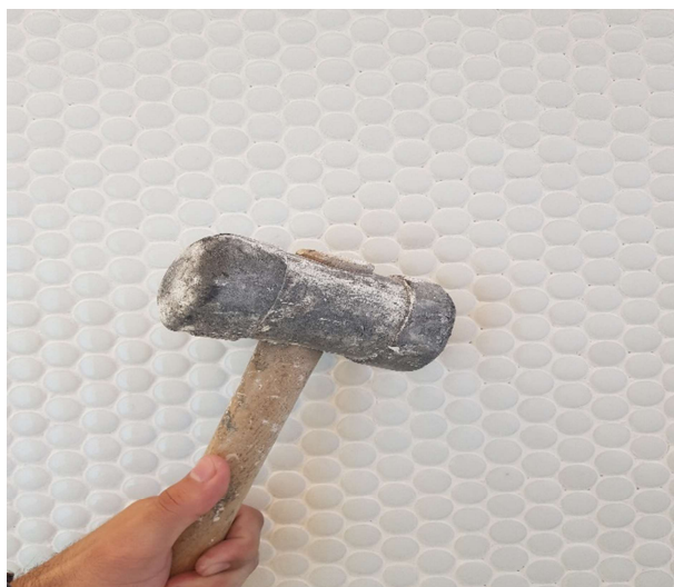
Figura 2.9 – Teste de percussão com uso de martelo (Autor, 2017)
