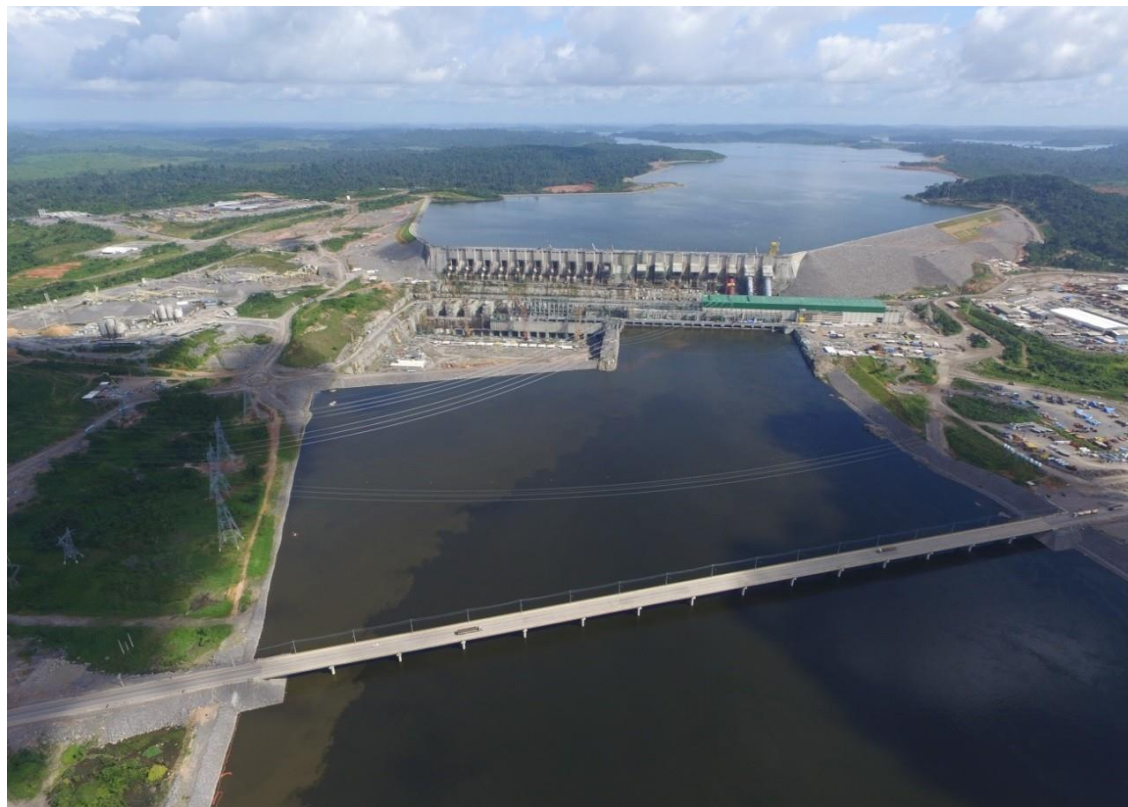
FIGURA 13: O SIGNIFICADO DA UHE BELO MONTE PARA O EMPREENDEDOR: a Usina representa a mais relevante obra do Programa de Aceleração do Crescimento – PAC.
