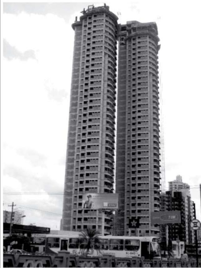
Figura 2 – Edifício monitorado (torre da esquerda)
