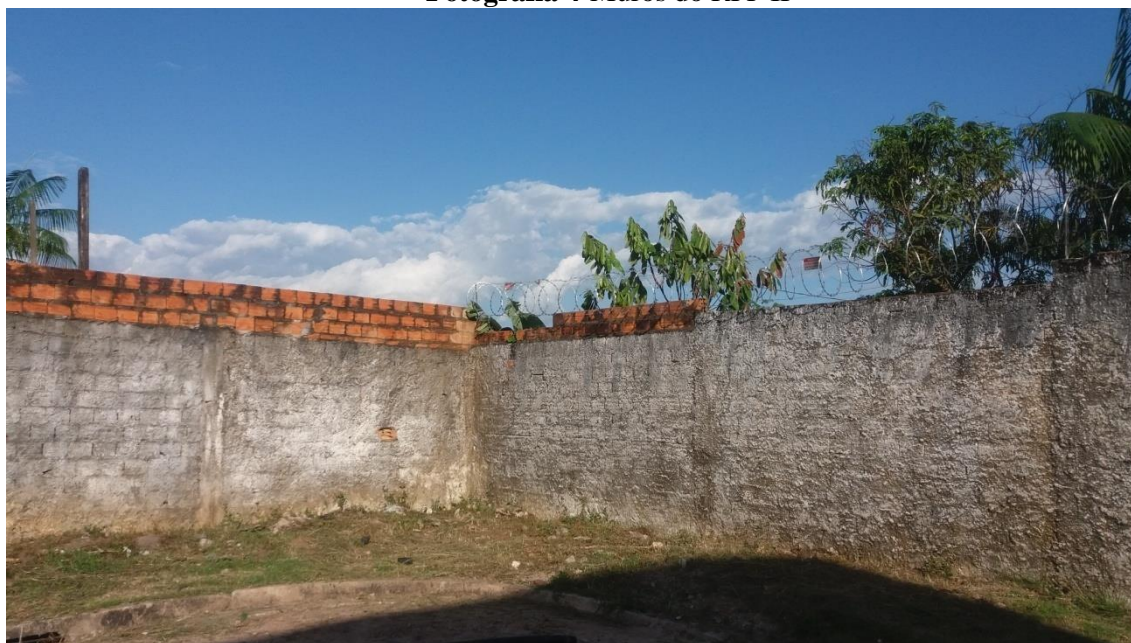
Fotografia 4- Muros do RPF II
