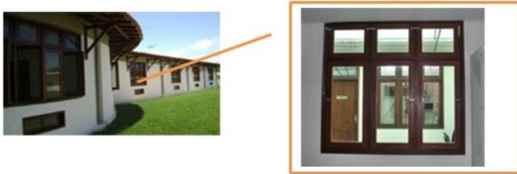
Figura 2.15. Janelas típicas da edificação.
