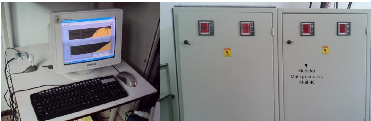
Figura 3.8. Computador que gerencia a rede Modbus e medidores instalados no quadro geral de distribuição.
