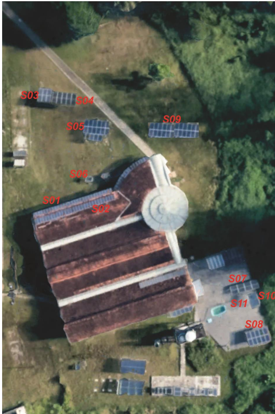
Figura 3.32. Vista aérea da área externa do Laboratório. Fonte: Adaptada do GoogleEarth.
