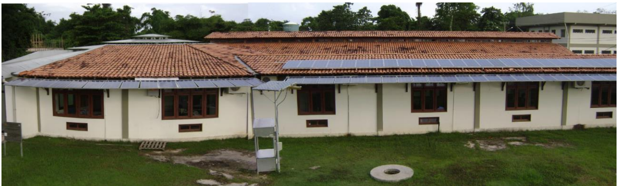
Figura 2.11. Fachada norte da edificação.
