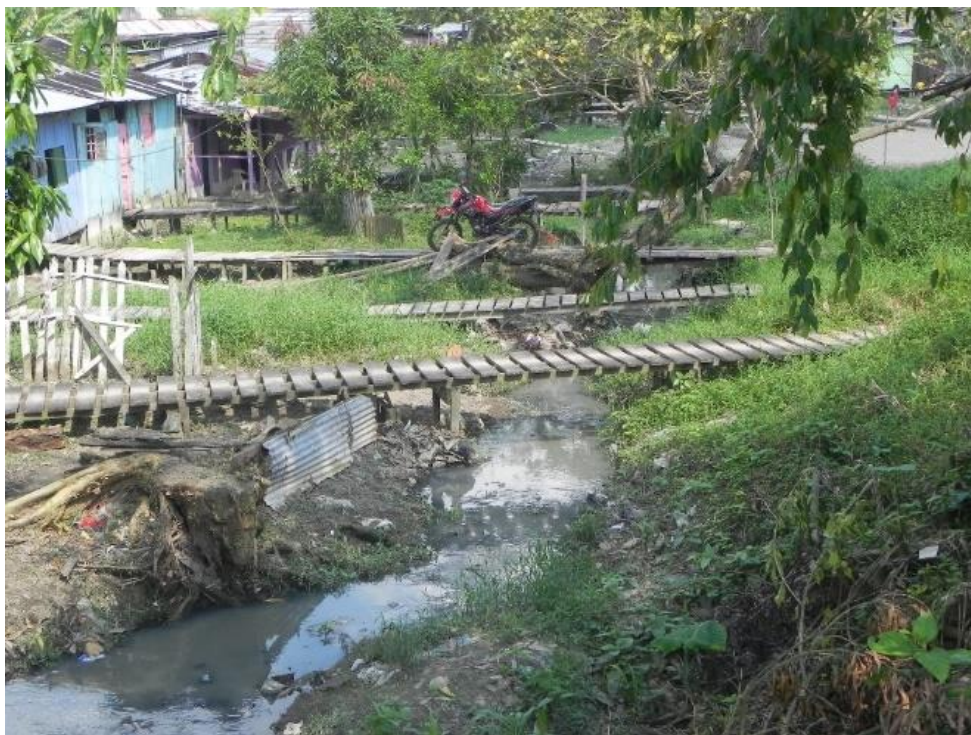
Fotografia 25 - Leito do Igarapé com água contaminada, segue em direção ao Rio Solimões e ao Ponto de captação de água para abastecimento de Tabatinga.
