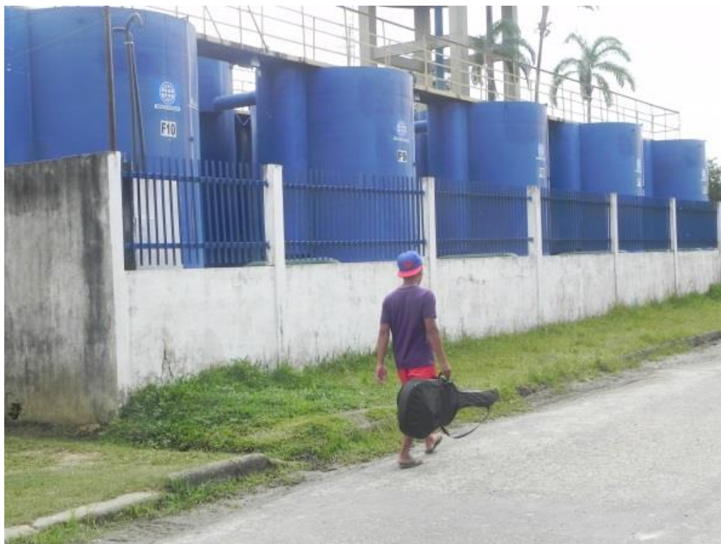
Fotografia 8 – Sistema de tratamento de água em Tabatinga.
