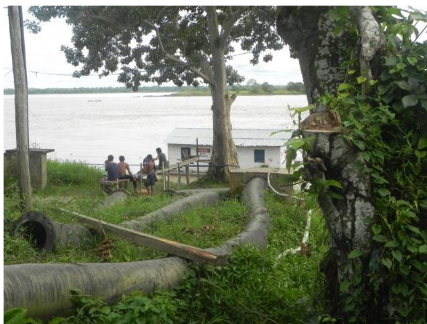
Fotografia 7 – Sistema de captação de água em Tabatinga.
