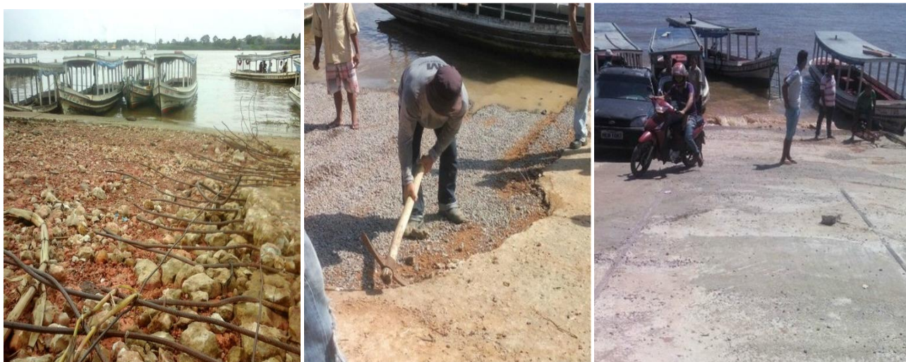
Fotografia 7 – Rampa de acesso dos moradores da ilha antes, durante e depois da reforma
