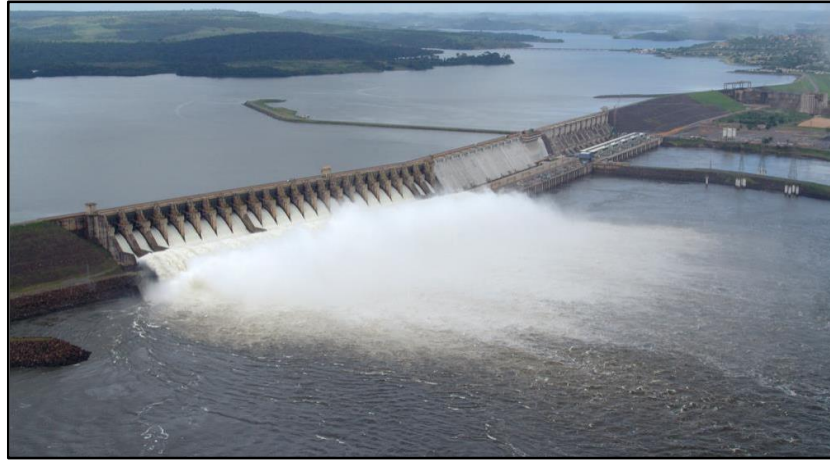
Figura 1 - Usina Hidrelétrica de Tucuruí
