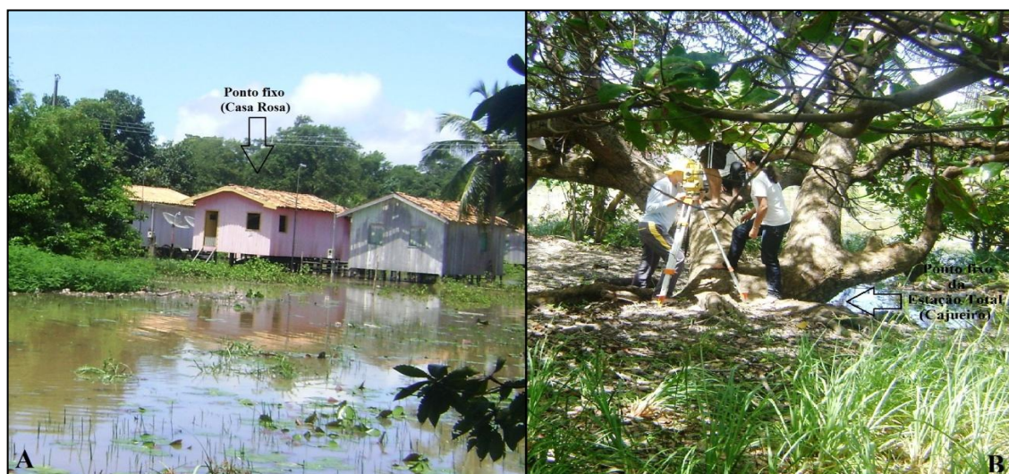
Figura 20- A) Estabelecimento do ponto fixo de ré (casa rosa) e B) do ponto fixo da estação total (Cajueiro).
