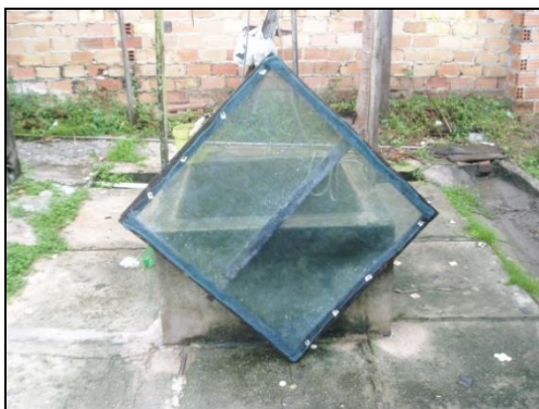
Figura 65 - Vedação do Poço P07.
