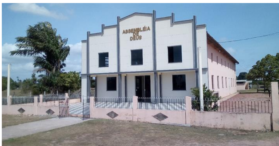
Figura 18: Templo central da Assembleia de Deus na comunidade de Retiro Grande. Fonte: arquivo pessoal.
