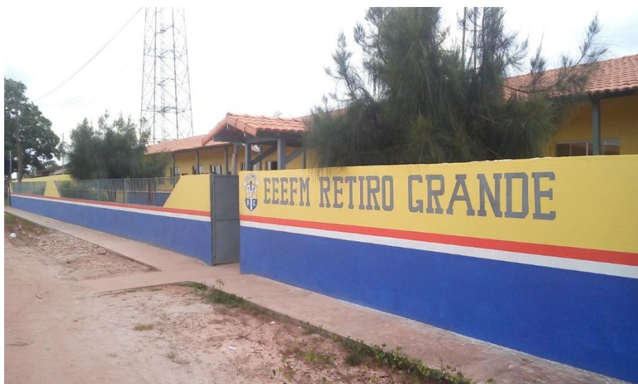
Figura 16: Obras quase concluídas – bloco 1 – E.E.E.F.M. Retiro Grande (março de 2018). Fonte: arquivo pessoal.
