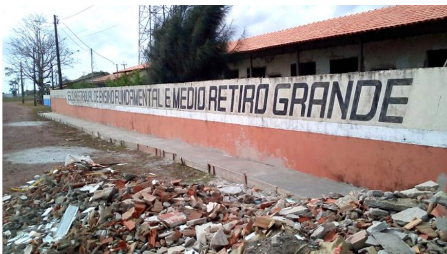
Figura 15: Obras em andamento – bloco 1 – E.E.E.F.M. Retiro Grande (outubro de 2017). Fonte: arquivo pessoal.
