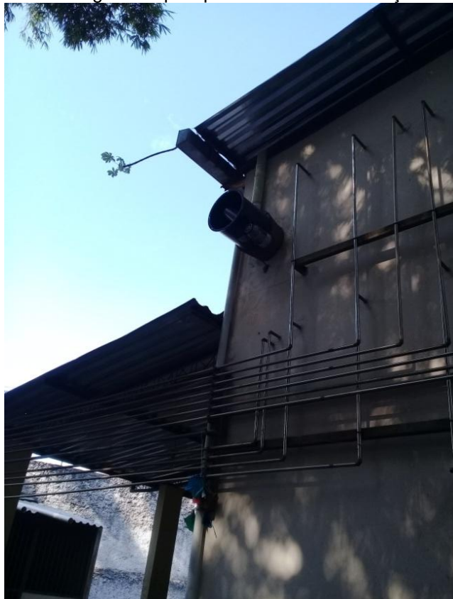
Figura 17: Exaustor com filtragem simples para a saída das fumaças emitidas pelos motores
