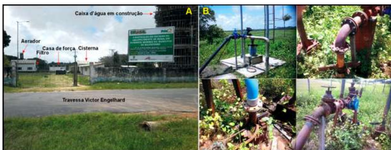
Figura 3. (A) - Área da estação de bombeamento e tratamento da água subterrânea da COSANPA de Salvaterra. (B) - Os 4 poços perfurados pela COSANPA com profundidades de 80 metros da estação de bombeamento e tratamento de água.
