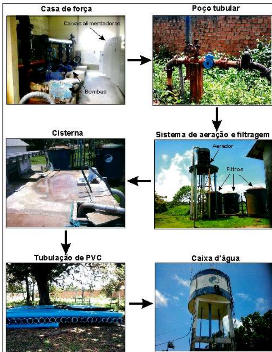
Figura 5. Sistema de abastecimento de água da COSANPA. As setas indicam o funcionamento do sistema desde a extração da água subterrânea até o seu destino final.
