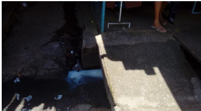
Figura 8.1- Esgoto dos estabelecimentos comerciais correndo a céu aberto.
