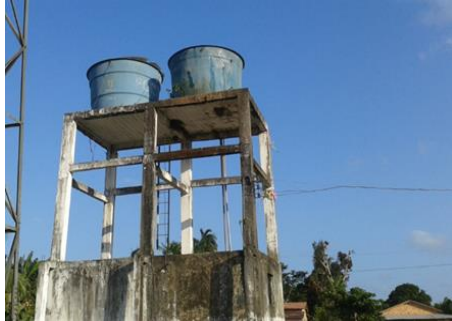
Figura 14- Aproveitamento de água a partir de poços mantidos pela Prefeitura na área rural: (a) Caixa d'água na comunidade do Caranã, 2 caixas de 5 mil litros cada, abastecem aproximadamente 100 casas da parte central da comunidade, profundidade de 19m; (b) Caixa d'água na Comunidade Ilha dos Pintos, sem estimativa do quantitativo de casas abastecidas, profundidade de 12m; (c) e (d) Caixa d'água na Comunidade de São Mateus, de 10 mil litros, abastece 22 casas, profundidade de 30m.
