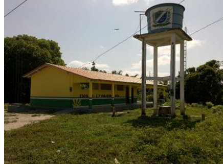
Figura 14- Aproveitamento de água a partir de poços mantidos pela Prefeitura na área rural: (a) Caixa d'água na comunidade do Caranã, 2 caixas de 5 mil litros cada, abastecem aproximadamente 100 casas da parte central da comunidade, profundidade de 19m; (b) Caixa d'água na Comunidade Ilha dos Pintos, sem estimativa do quantitativo de casas abastecidas, profundidade de 12m; (c) e (d) Caixa d'água na Comunidade de São Mateus, de 10 mil litros, abastece 22 casas, profundidade de 30m.
