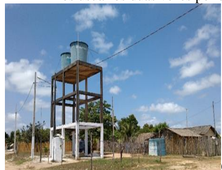
Figura 15- Aproveitamento de água a partir de poços mantidos pela Prefeitura na área urbana: (a) Caixa d'água no Bairro Nova Esperança, profundidade de 60m; (b) Caixa d'água da invasão do Hospital Municipal, profundidade de 62m; (c) Caixa d'água no Bairro Nova Esperança, profundidade de 55m; (d) Caixa d'água no Bairro Nova Esperança, três caixas de 20 mil litros cada, liberadas para os usuários duas vezes por dia, durante 40 minutos, profundidade de 30m.
