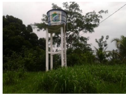
Figura 15- Aproveitamento de água a partir de poços mantidos pela Prefeitura na área urbana: (a) Caixa d'água no Bairro Nova Esperança, profundidade de 60m; (b) Caixa d'água da invasão do Hospital Municipal, profundidade de 62m; (c) Caixa d'água no Bairro Nova Esperança, profundidade de 55m; (d) Caixa d'água no Bairro Nova Esperança, três caixas de 20 mil litros cada, liberadas para os usuários duas vezes por dia, durante 40 minutos, profundidade de 30m.
