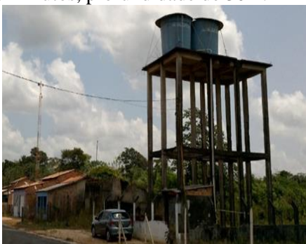
Figura 15- Aproveitamento de água a partir de poços mantidos pela Prefeitura na área urbana: (a) Caixa d'água no Bairro Nova Esperança, profundidade de 60m; (b) Caixa d'água da invasão do Hospital Municipal, profundidade de 62m; (c) Caixa d'água no Bairro Nova Esperança, profundidade de 55m; (d) Caixa d'água no Bairro Nova Esperança, três caixas de 20 mil litros cada, liberadas para os usuários duas vezes por dia, durante 40 minutos, profundidade de 30m.
