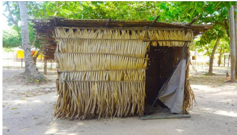
Fotografia 17 - Instalação sanitária em Taperebateua
