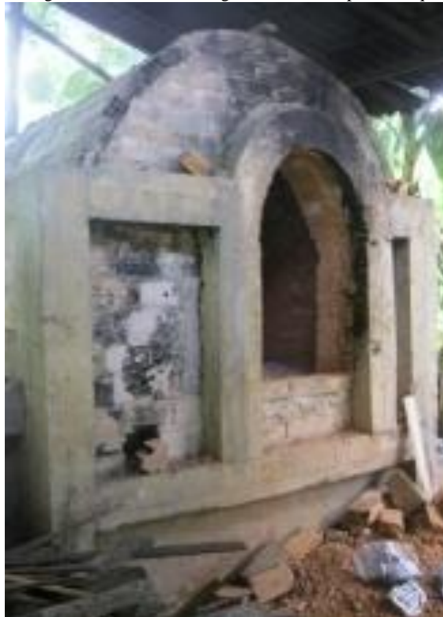
Fotografia 16 - Forno noborigama construído por Henoque
