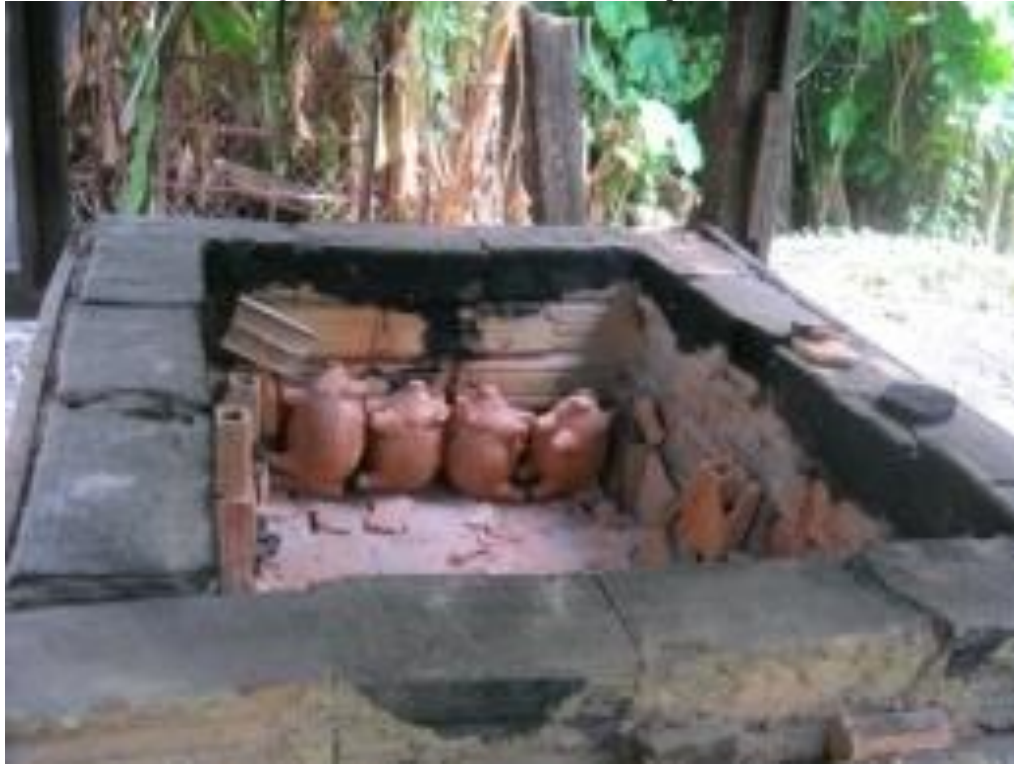
Fotografia 15 – Forno caieira construído por artesãos
