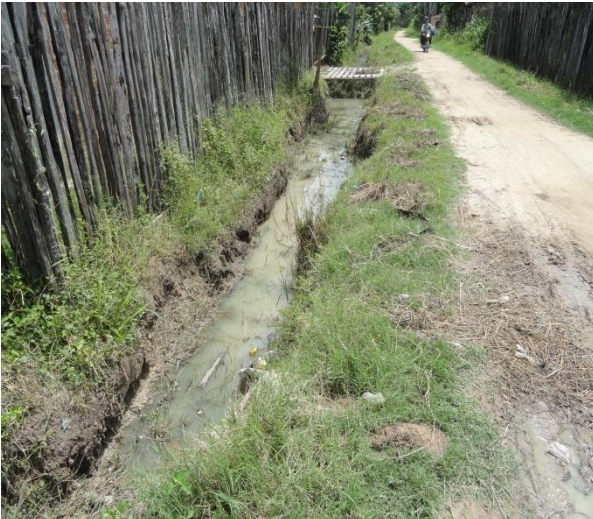
Fotografia 7 – Valas abertas, improvisadas Pelos moradores do bairro Cidade Nova
