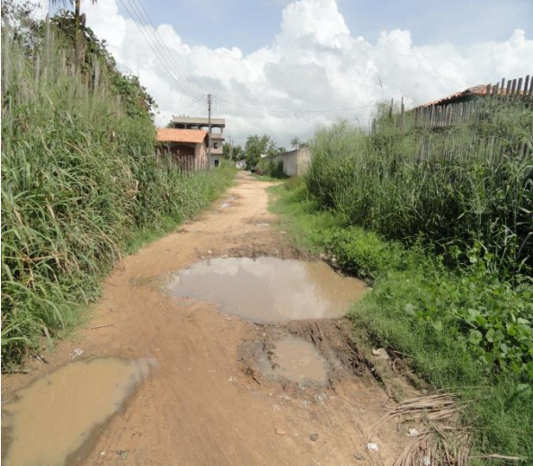
Fotografia 5 – condição das ruas no Bairro Jardim Primavera.
