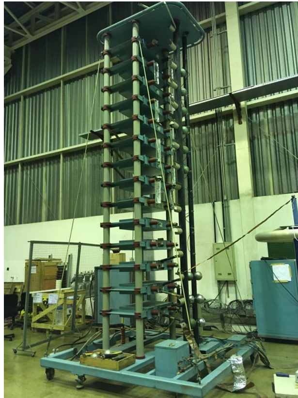
Figura 18 – Gerador de impulsos de tensão 1400kV do IEE-USP.
