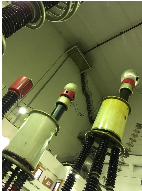
Figura 19 – Transformadores em cascata do IEE-USP.
