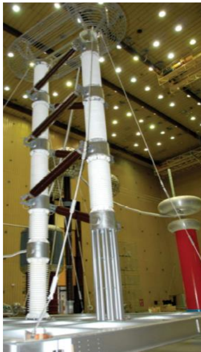
Figura 10 – Retificador 1000kV do Centro de Pesquisas da Eletrobrás.
