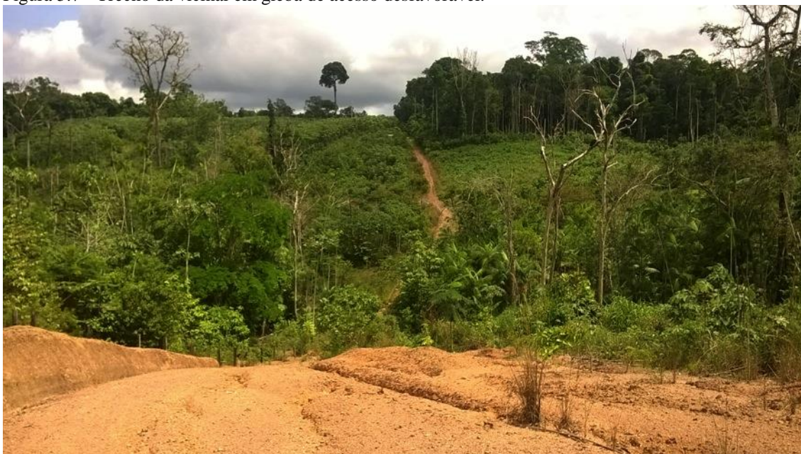
Figura 5.7 - Trecho da vicinal em gleba de acesso desfavorável.
