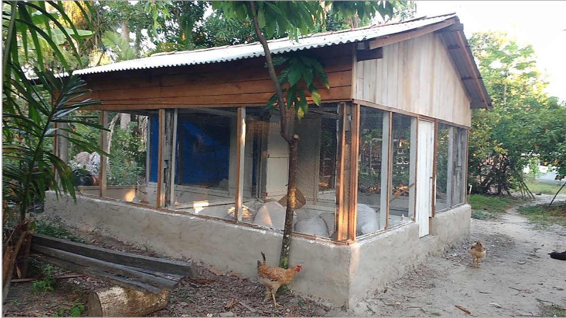
Figura 7: Instalação construída recentemente para o escalonamento da criação.
