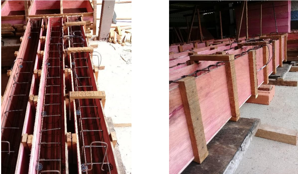
Figura 3.1 – Fôrmas utilizadas na produção das vigas.
