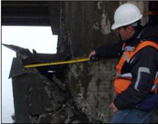
a) Ruptura por cisalhamento de pilar no extremo norte da ponte Juan Pablo II, Chile, 2010. Fonte: https://www.fhwa.dot.gov/publications/research/infrastructure/structures/11030/004.cfm
