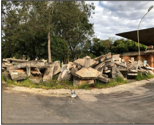
Figura 1.1 - Aterro de elementos de concreto e processo de demolição para descarte
