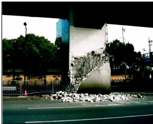
b) Ruptura por cisalhamento de Pilar de concreto armado, Maekawa e An, (2000).
