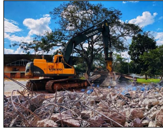
Figura 1.1 - Aterro de elementos de concreto e processo de demolição para descarte
