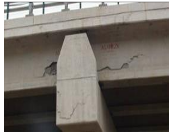
c) Ruptura por cisalhamento de viga pré-moldada de um viaduto, Chile, 2010. Fonte : https://www.fhwa.dot.gov/publications/research/infrastructure/structures/11030/004.cfm
