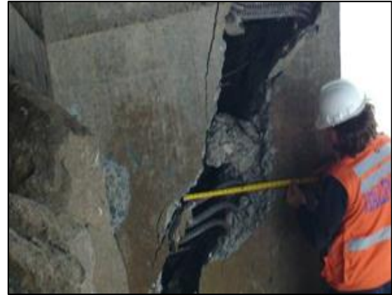
a) Ruptura por cisalhamento de pilar no extremo norte da ponte Juan Pablo II, Chile, 2010. Fonte: https://www.fhwa.dot.gov/publications/research/infrastructure/structures/11030/004.cfm
