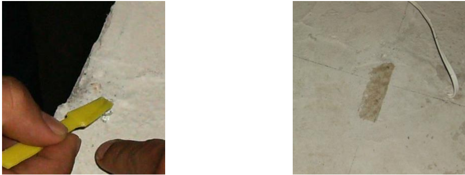
Figura 4.22 – Colocação dos extensômetros no concreto
