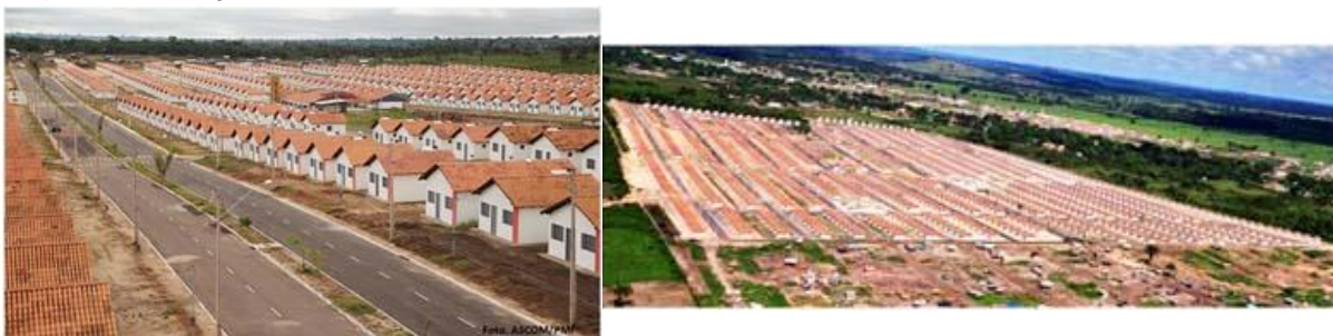
Figura 33: Conjunto Habitacional Wirland Freire
