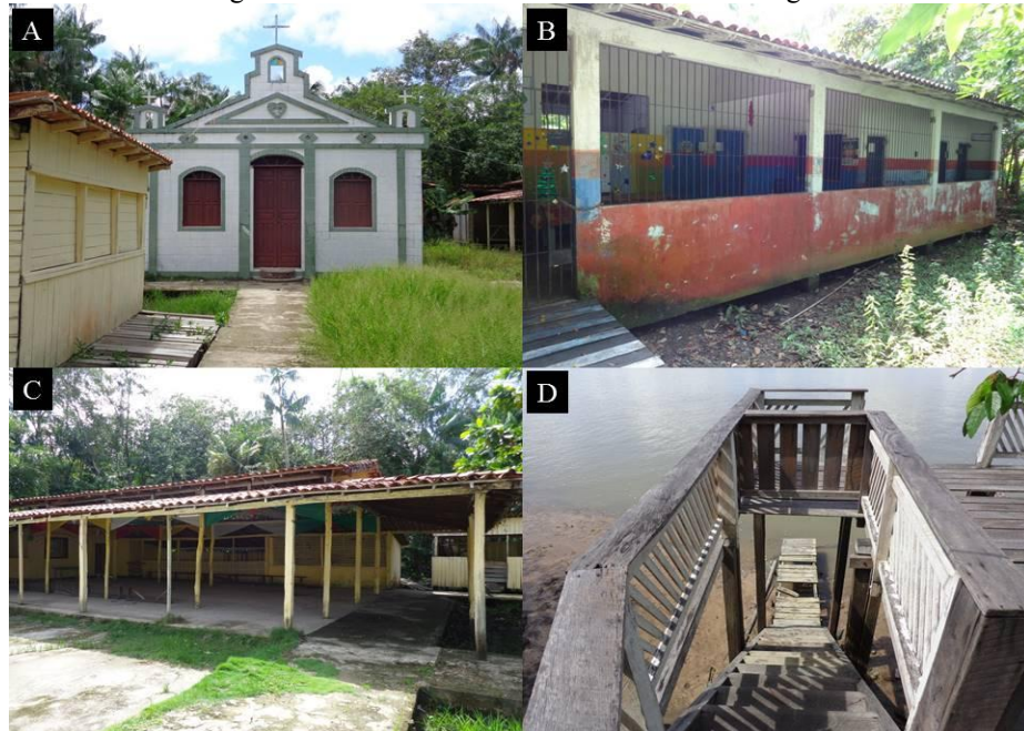
Figura 12 - Infraestrutura da comunidade São Miguel
