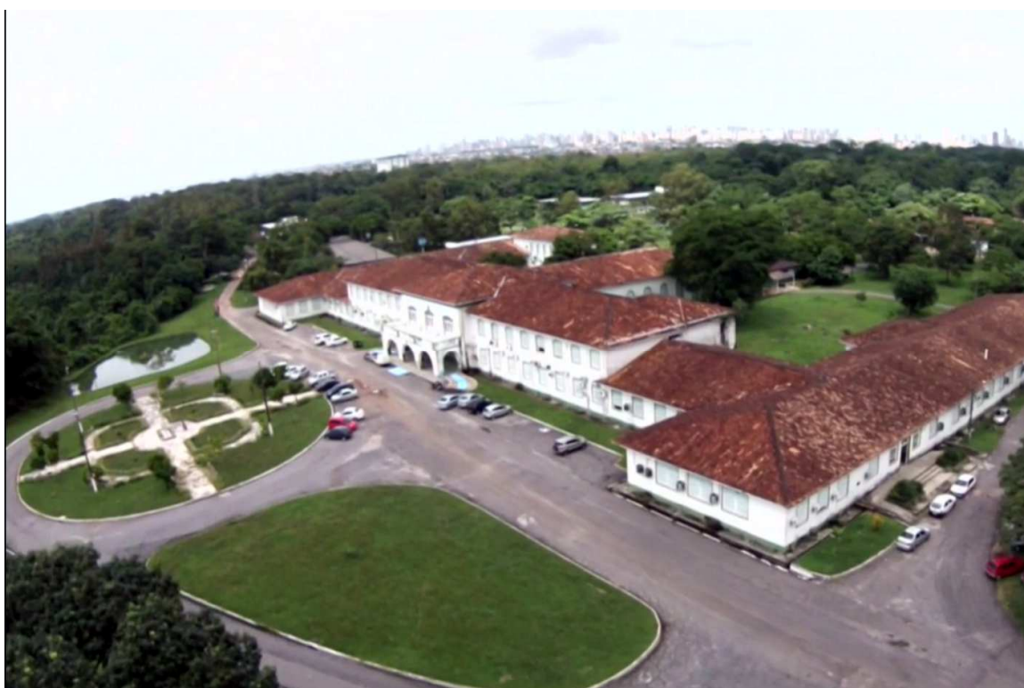
Figura 03 - Vista aérea da área do Prédio Centra da UFRA
