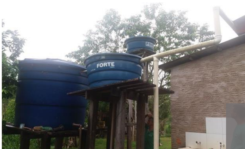
Figura 89 – Rebaixamento das instalações
