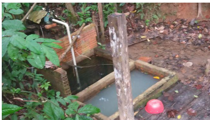
Figura 72 – Instalação de recalque das fontes d'água
