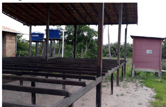
Figura 88 – Moradia inacabada beneficiada
