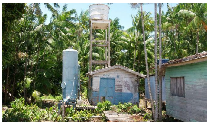
Figura 73 – Antigo sistema de abastecimento da CAESA
