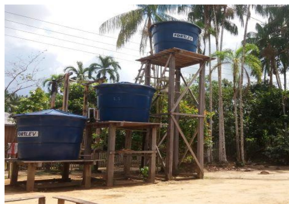
Figura 77 – Sistema Pluvial Multiuso Comunitário em Gumo do Fação
