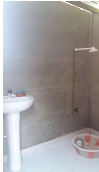
Figura 91 – Altura reduzida do telhado
