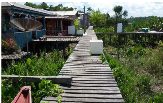
Figura 59 – Passarela de acesso, S. Antônio
