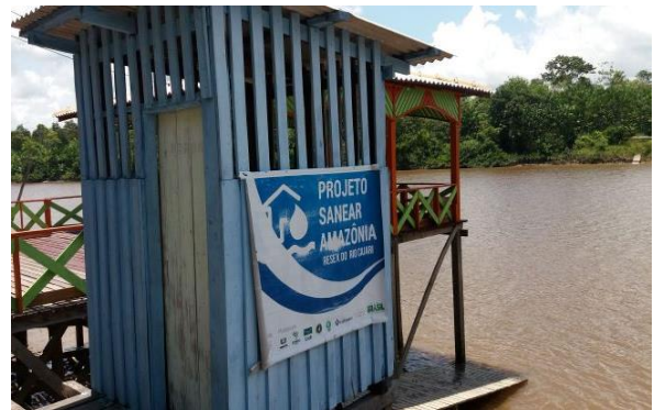
Figura 75 – Abrigo da bomba do sistema coletivo
