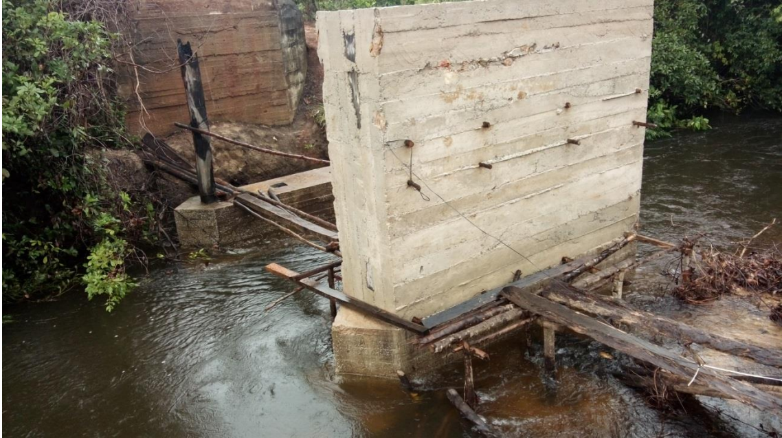
Figura 12 - Detalhe dos pilares de sustentação e o acesso improvisado com tábuas na base da ponte incendiada que dá acesso ao quilombo Mumbuca
