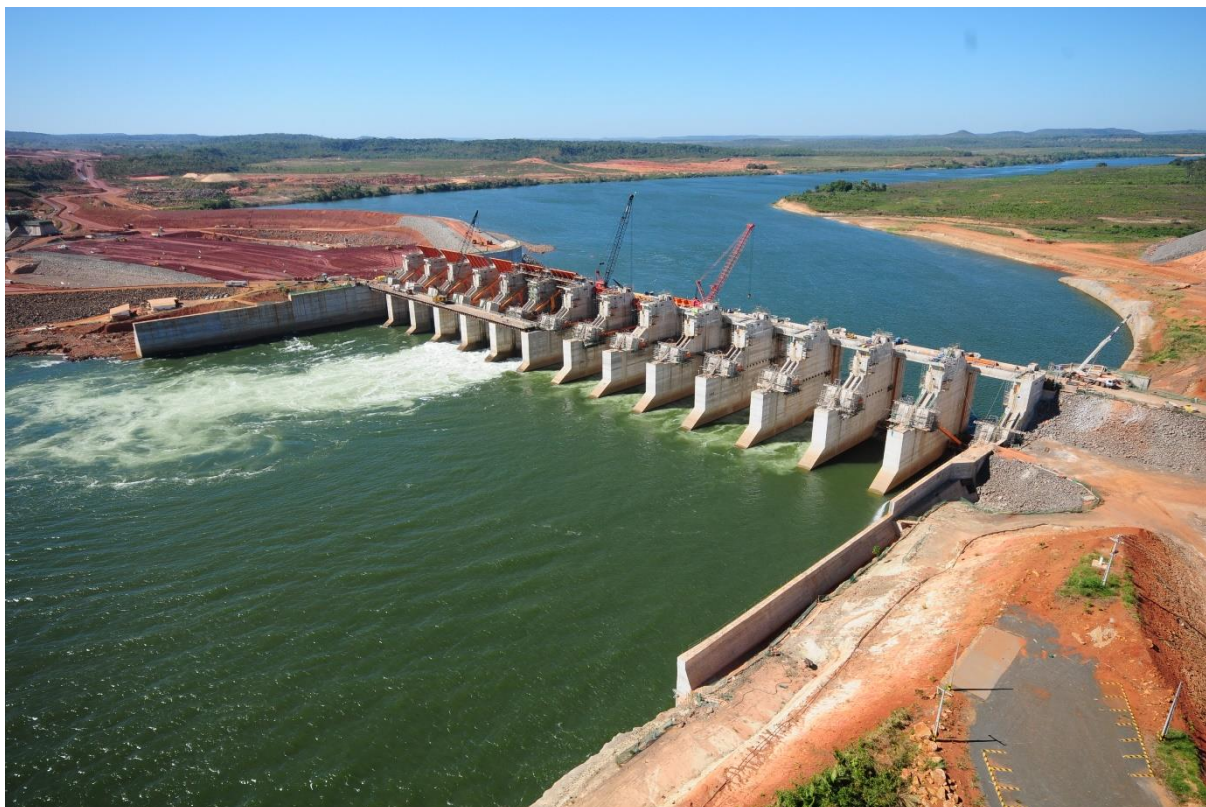
Figura 8 - Usina hidrelétrica do tipo fio d'água no município de Estreito-MA.
