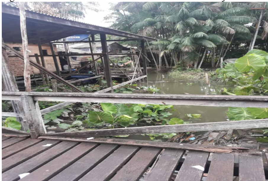
Figura 10 - Falta de saneamento básico em Limoeiro do Ajuru
