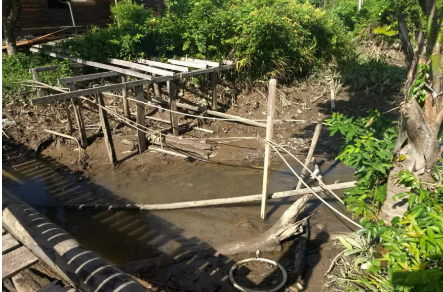
Figura 9 - Encanação de abastecimento de água urbana em Limoeiro do Ajuru.
