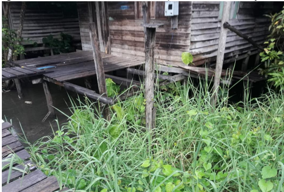
Figura 11 - Casa em área de risco à inundação em Limoeiro do Ajuru.
