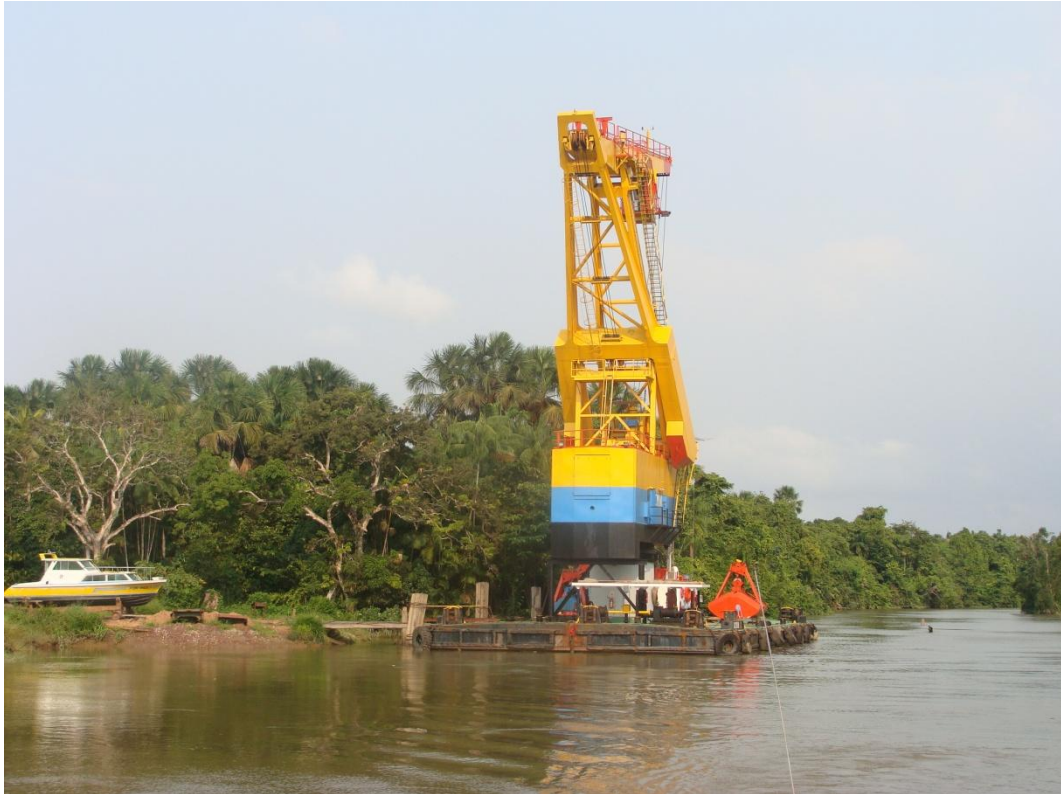
Figura 3 - Instalações da USIPAR às margens do rio Arienga. Notar o sistema de dragagem da margem esquerda do rio Arienga para construção do atracadouro da USIPAR.
