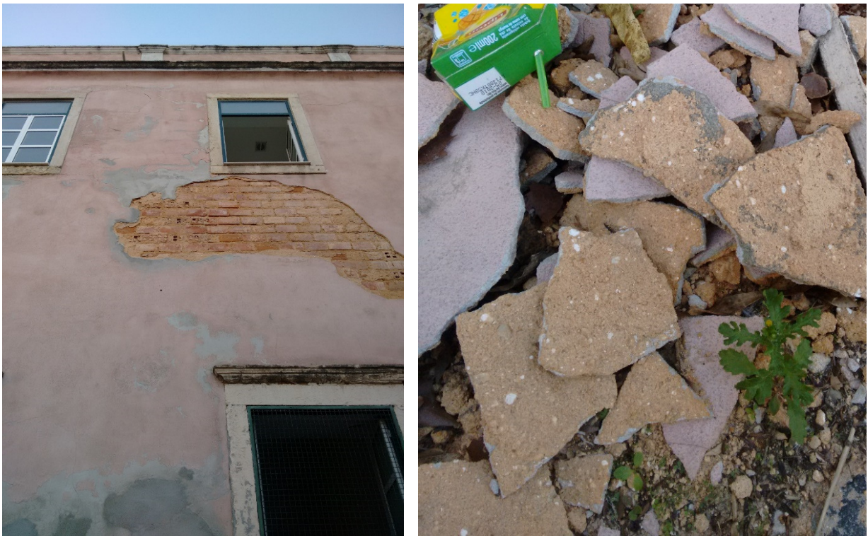
Figura 2: Problema de destacamento do reboco após aplicação de argamassa de cimento em edifício histórico, sendo possível constatar que o material incompatível traz consigo o material histórico.
