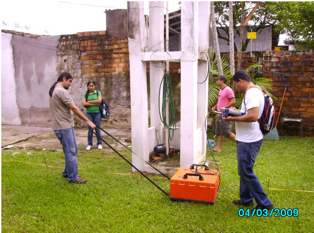
Figura 5.1 – Levantamento com GPR realizado próximo a um poço de abastecimento domiciliar nos fundos do Posto Cristal
