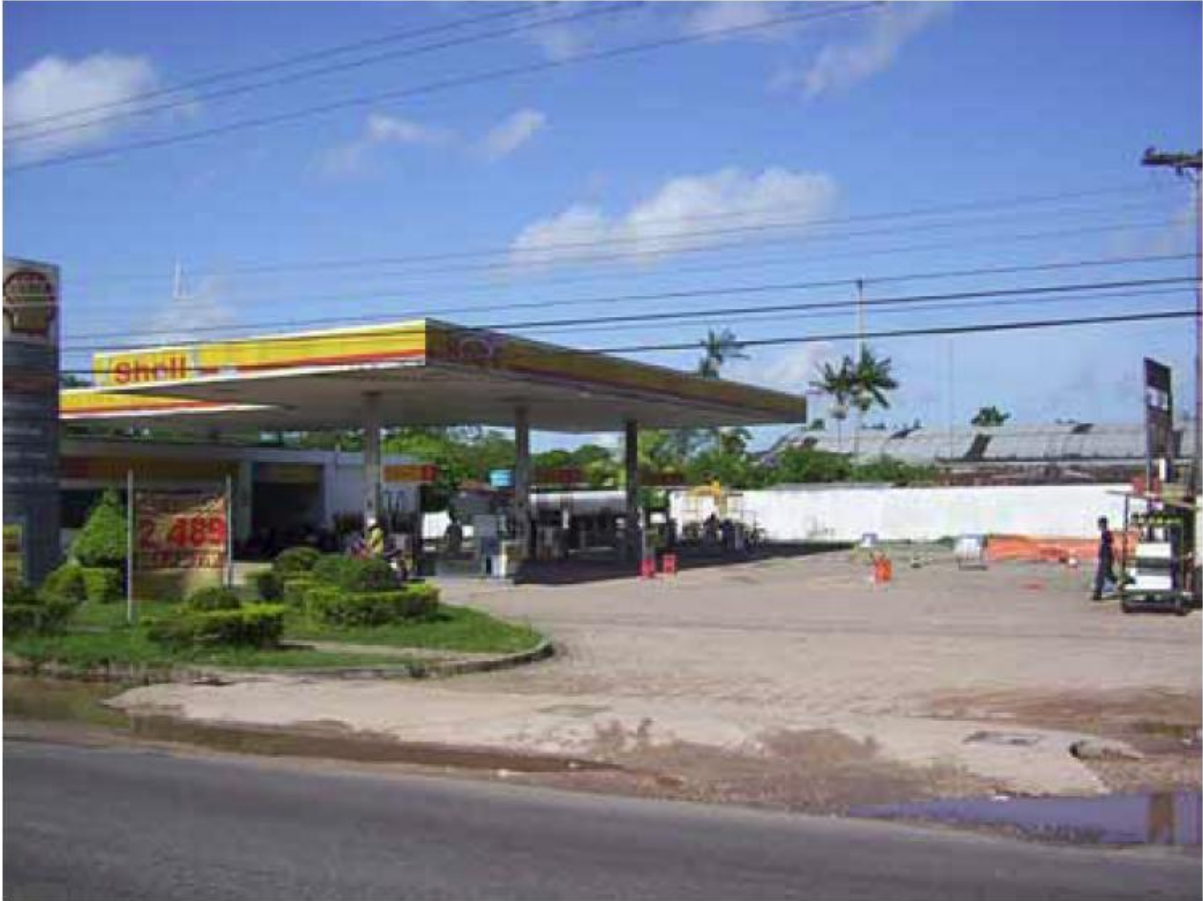
Figura 1.1- Posto Cristal, Rodovia Augusto Montenegro, Belém-PA.
