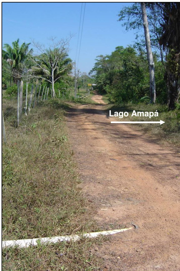
Figura 33 - Possível emissário saindo de uma propriedade (piscicultura) em direção ao lago Amapá. Depois de cruzar a estrada de terra, não é possível visualizar o prolongamento da tubulação. Provavelmente, termina dentro do lago, subterraneamente.
