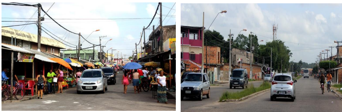
Fotografia 2 - Tráfego de pedestres e veículos na rua Betânia (à esquerda) e condições do pavimento na Rua Yamada (à direita).
