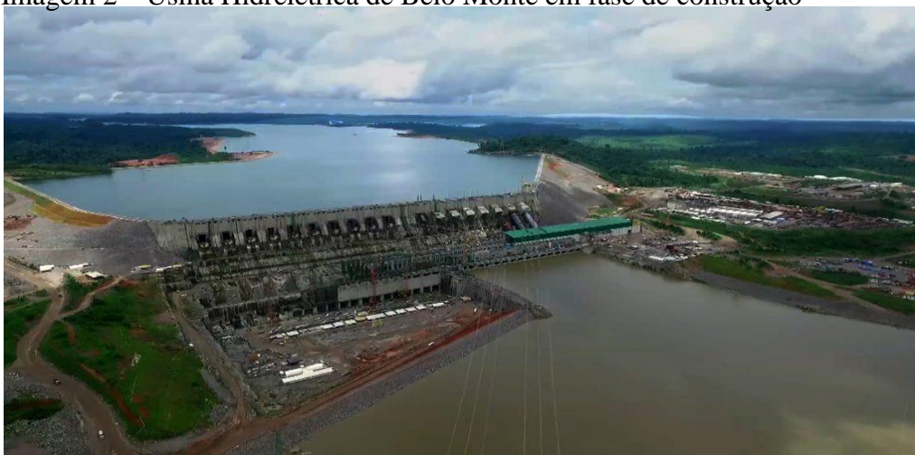
Imagem 2 – Usina Hidrelétrica de Belo Monte em fase de construção
