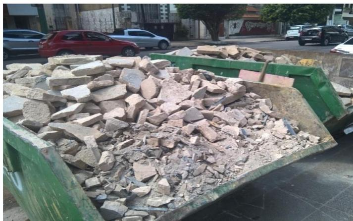
Figura 3.1 - Resíduo da construção civil (RCC) em fase de coleta.
