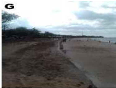
Imagem G - Muro de contenção para conter a erosão – Segmento Marahú (2017)
