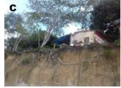
Imagens A, B e C - Erosão de falésia e residências com risco de desmoronamento – Segmento Paraíso (2017)
