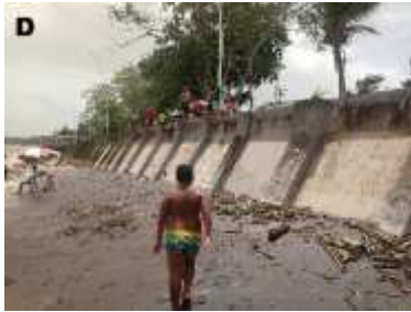
Imagens D, E e F - Muro de contenção para conter a erosão – Segmento Paraíso (2019)
