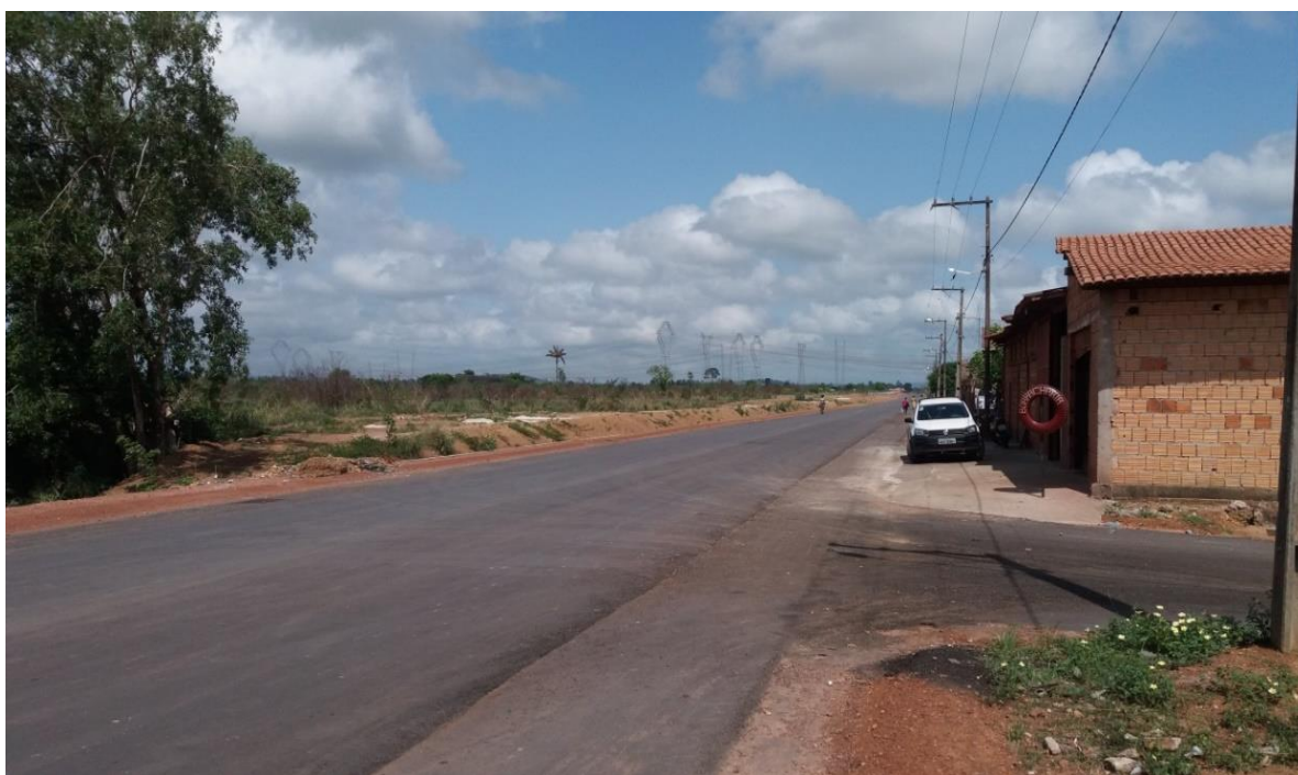
Figura 2 - Avenida Galet, bairro Santa Catarina à direita
