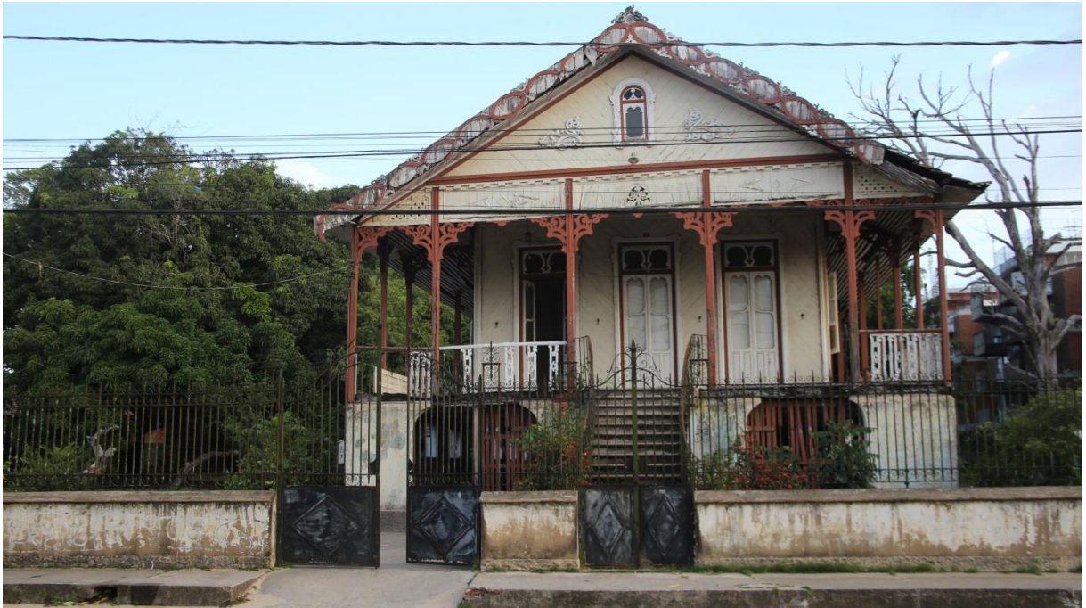
Figura 33 – Chalé 13, Praia do Chapéu Virado, Ilha de Mosqueiro. Fonte: Felipe Pamplona, 2018.
