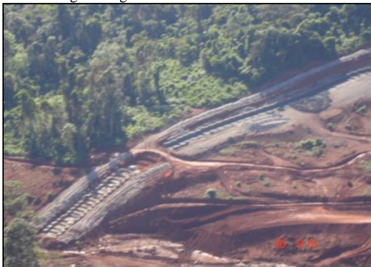
Figura 24 Descida de água em gabião construída na ombreira direita da PDE NW II.
