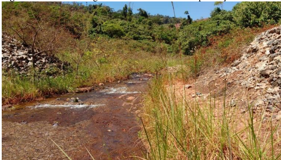
Figura 50 Ponto de deságue do cordão drenante sem presença de sedimento.
