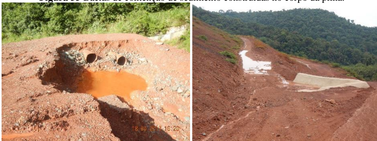
Figura 35 Bacias de contenção de sedimento construídas no corpo da pilha.
