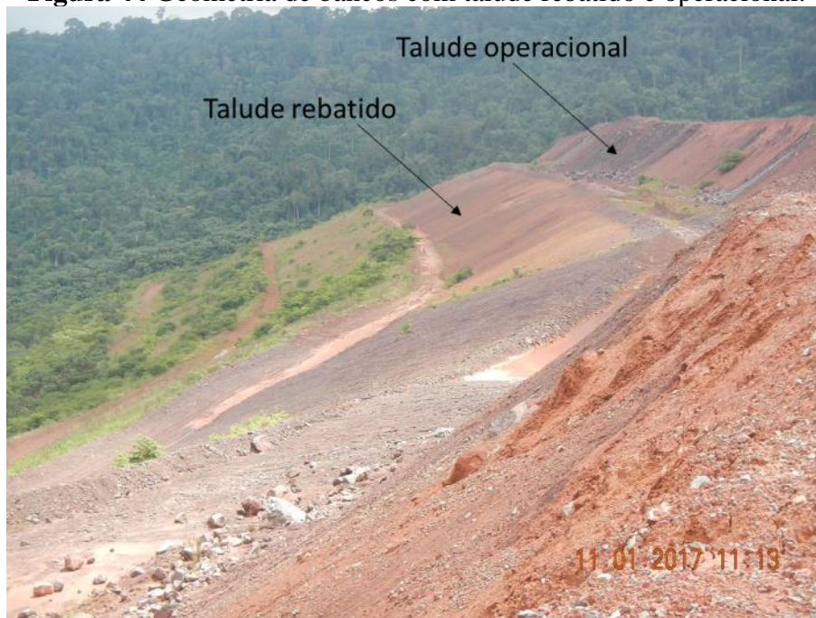
Figura 44 Geometria de bancos com talude rebatido e operacional.
