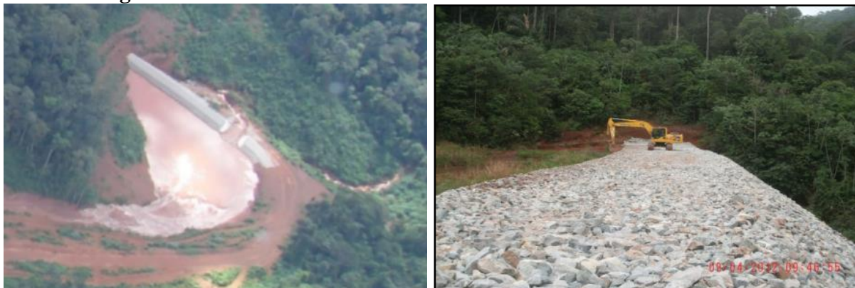
Figura 34 Visão aérea e do material de enrocamento do cordão drenante.
