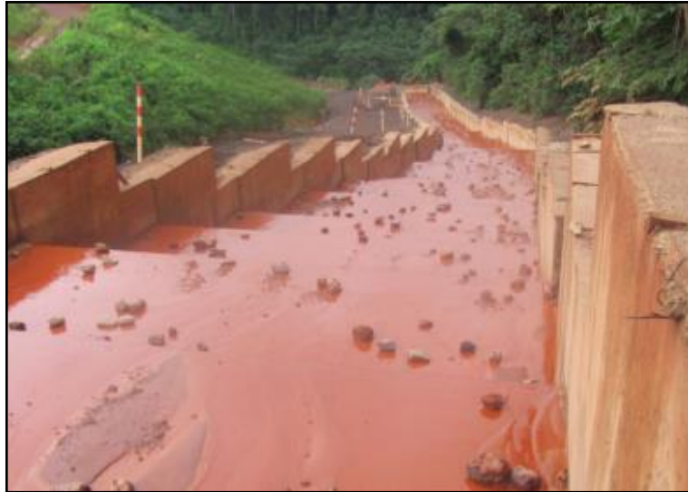
Figura 45 Transporte de sedimento pela drenagem superficial da estrutura.
