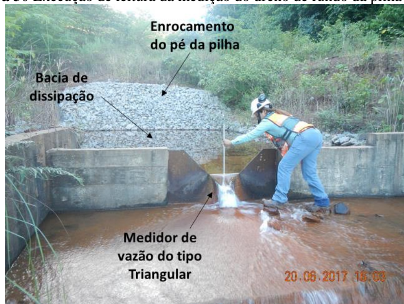
Figura 30 Execução de leitura da medição do dreno de fundo da pilha NW II.
