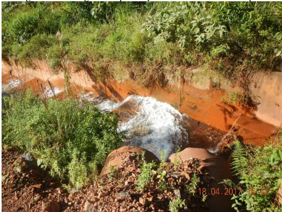
Figura 46 Desaguamento de água sem presença de sedimento no canal periférico da pilha.
