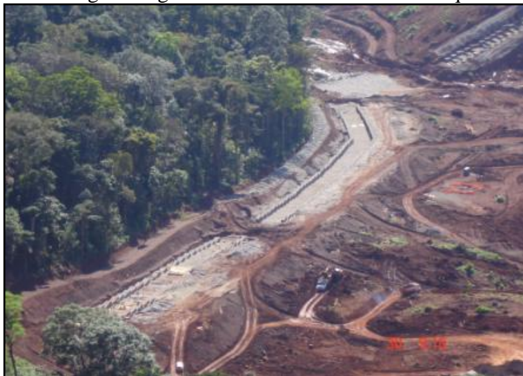
Figura 25 Descida de água em gabião construída na ombreira esquerda da PDE NW II.
