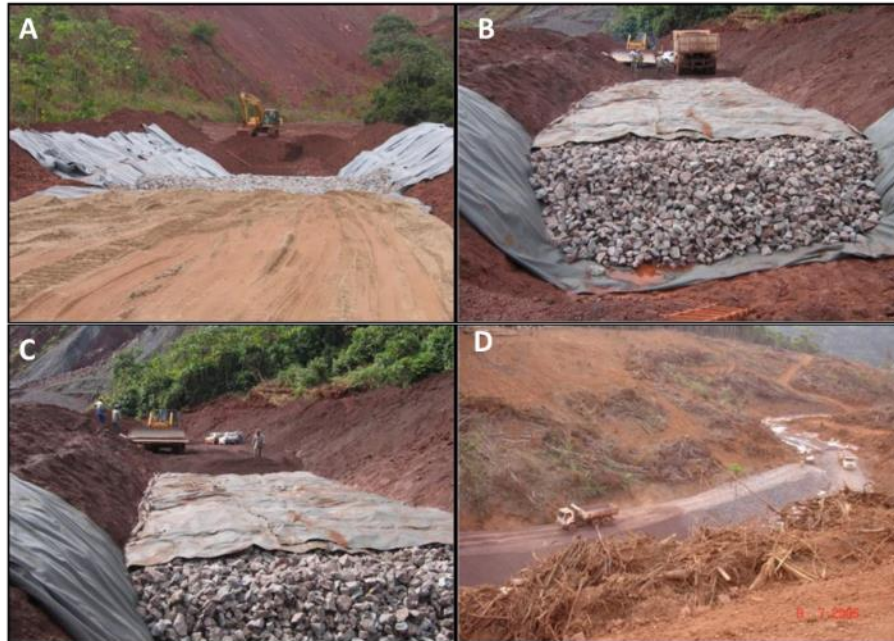
Figura 29 Fases do processo construtivo do dreno interno da pilha.
