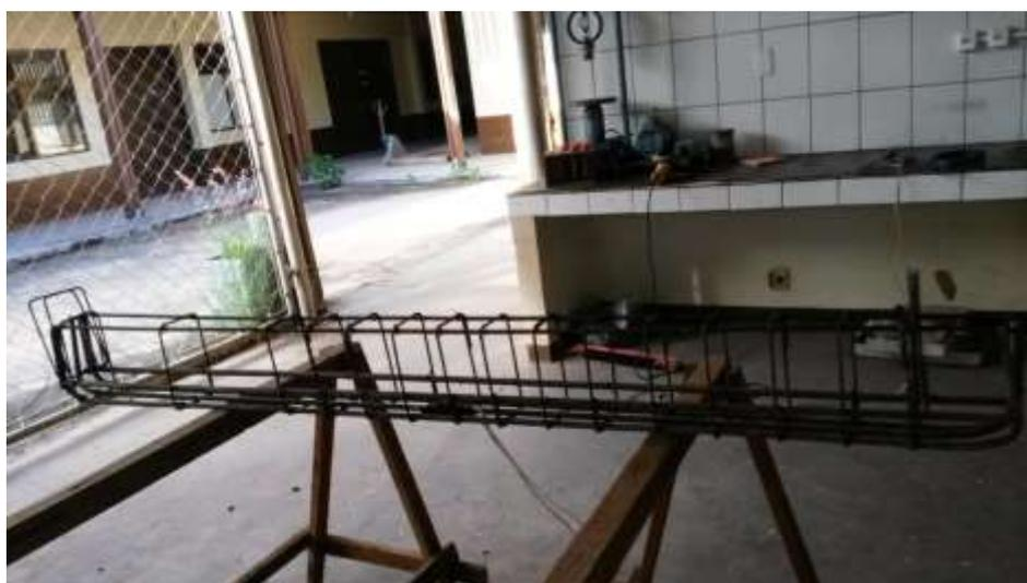
**Figura 3.11 – Armadura executada para a viga.**
