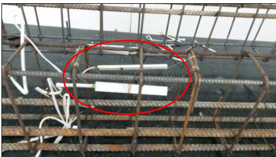
**Figura 3.14 – *Strain Gages* internos do concreto pronto para a execução da concretagem.**
