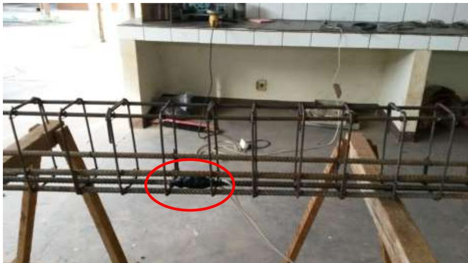
**Figura 3.13 – *Strain Gages* do aço colados e protegidos para a execução da concretagem.**
