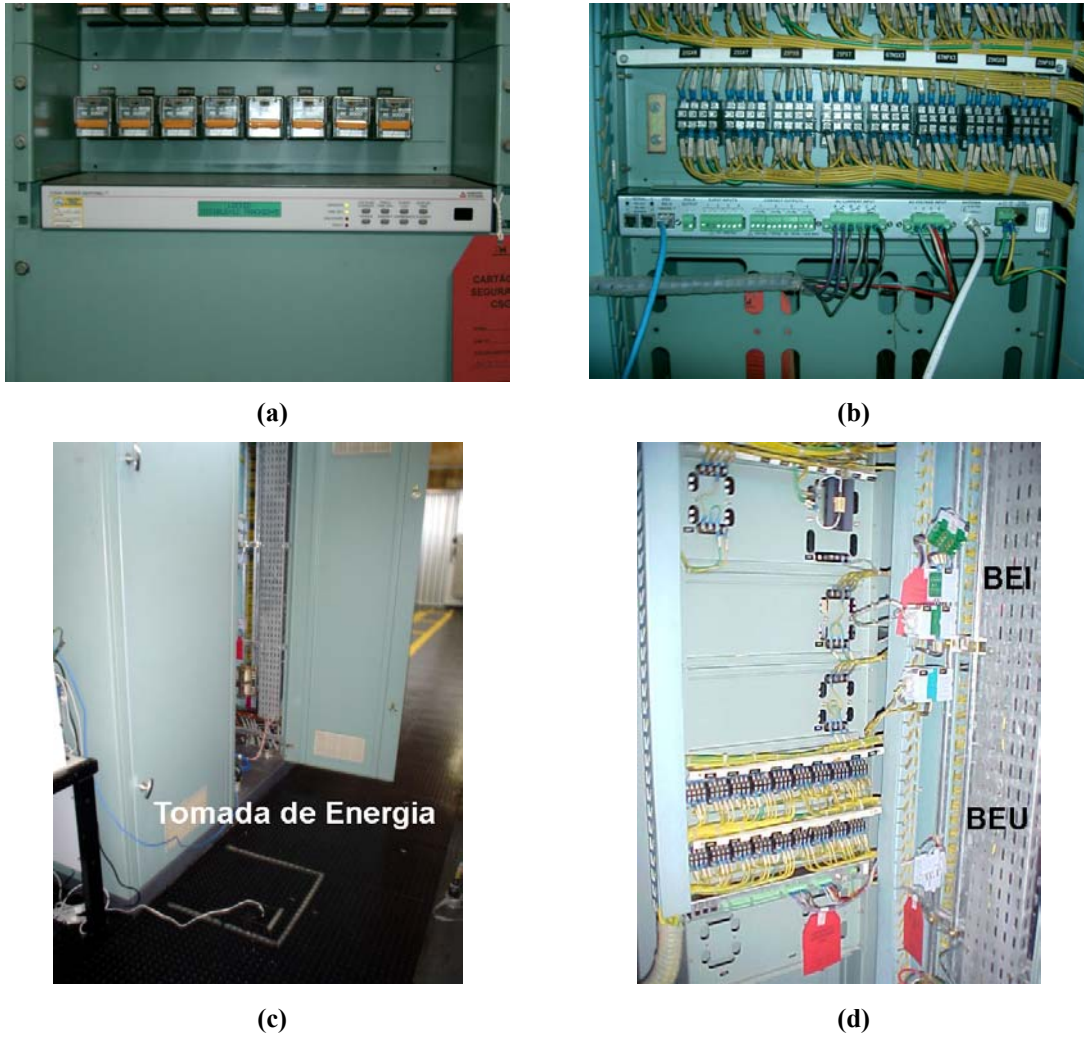
Figura 3. 9 - Aspectos da localização e instalação do medidor na SE-Guamá (a) Vista do medidor instalado em painel; (b) Vista das ligações no interior do painel; (c) Porta traseira do painel aberta para aquisição de dados; (d) Aspecto das ligações ao TC e TP, ainda com Cartões de Serviço
