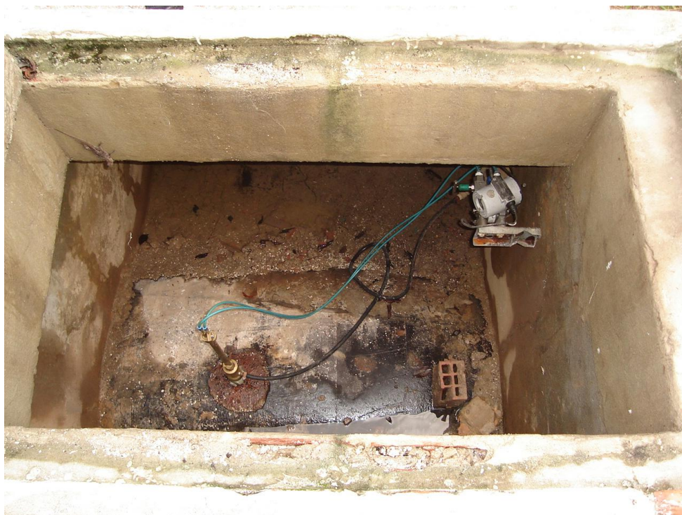
Fotografia 93: Tubo de Pitot interligando a adutora de água tratada da ETA Bolonha ao transmissor eletrônico para a leitura da vazão
