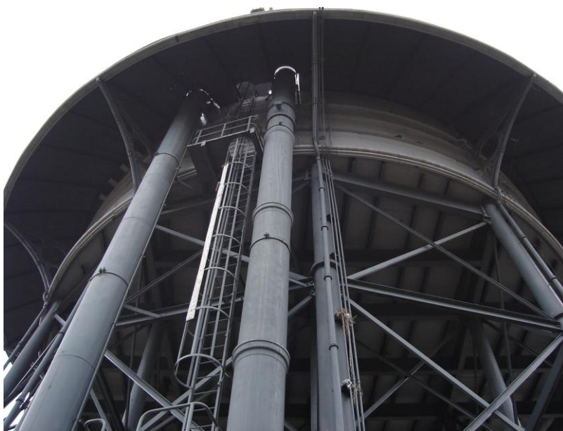
Fotografia 76: Reservatório apoiado do 6º Setor de abastecimento
