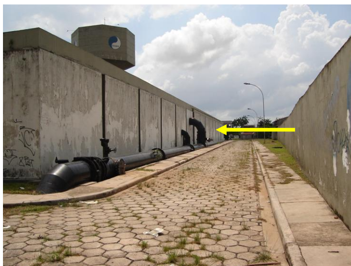
Fotografia 83: Chegada da adutora de água tratada no reservatório apoiado
