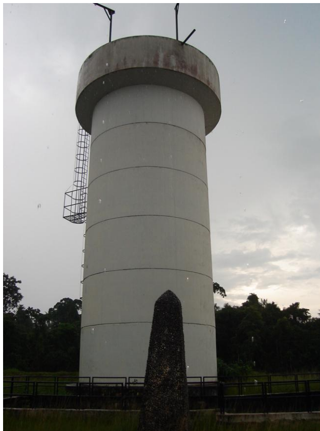
Fotografia 31: Tanque Amortecedor Unidirecional
