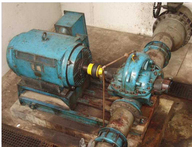
Fotografia 77: Conjunto motor-bomba da EAT – 6º Setor
