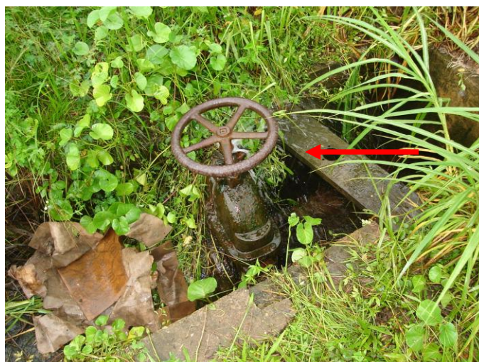
Fotografia 37: Vazamento na adutora Utinga – São Brás
