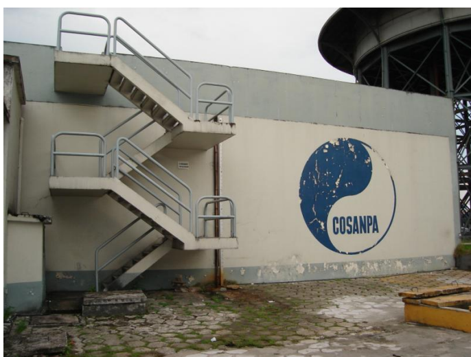
Fotografia 54: Reservatório Apoiado ETA São Braz
