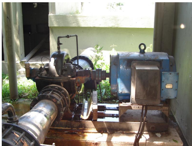
Fotografia 71: Bomba de recalque (cisterna – poço de captação)
