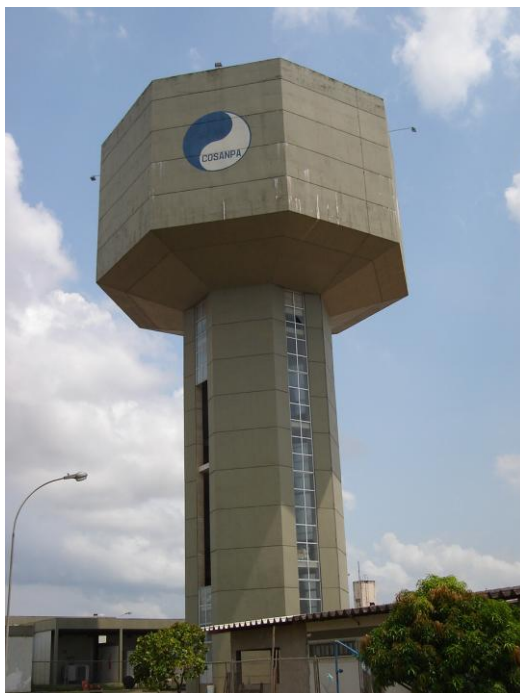
Fotografia 82: Reservatório apoiado do 8º Setor de abastecimento
