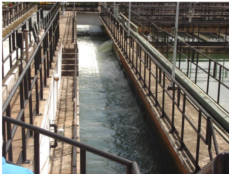
Fotografia 42: Saída dos efluentes dos decantadores ETA Bolonha
