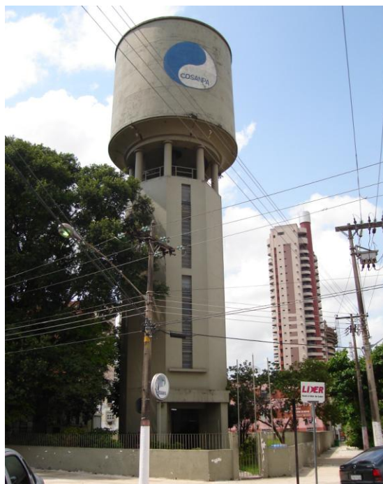
Fotografia 64: Reservatório apoiado do 3º Setor de abastecimento
