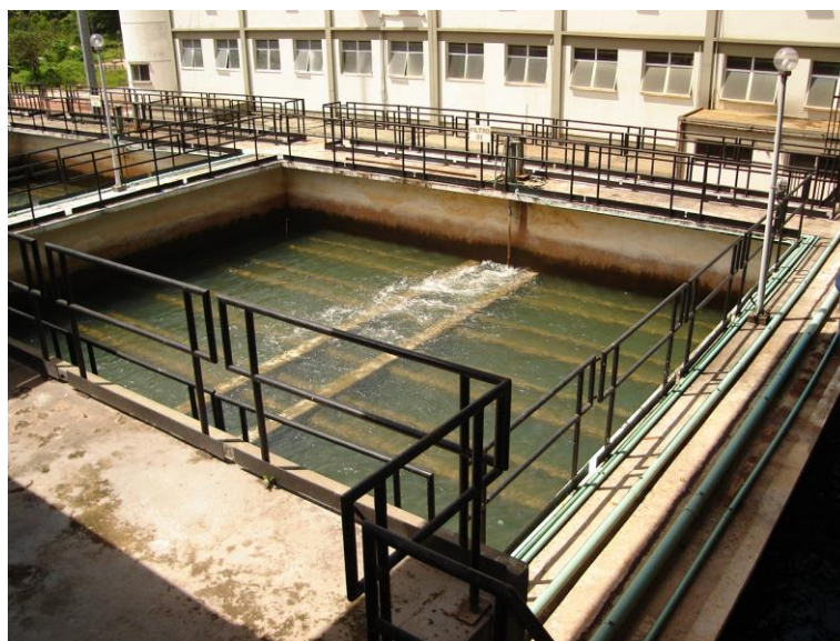
Fotografia 43: Filtro de escoamento descendente ETA Bolonha
