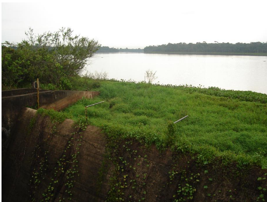
Fotografia 10: Extravador do lago Água Preta
