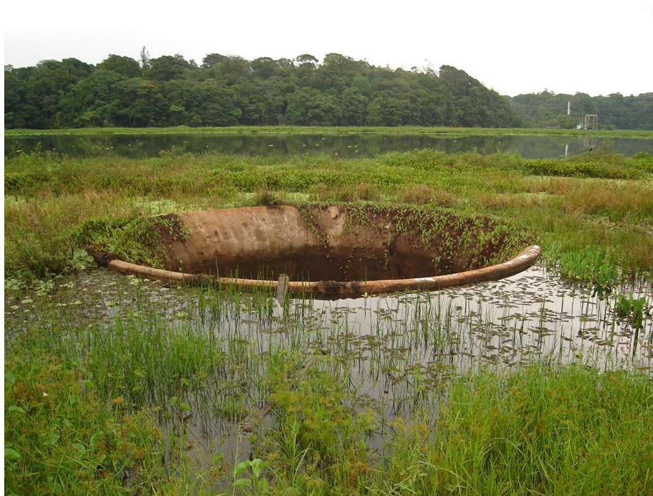
Fotografia 13: Extravasor do lago Bolonha
