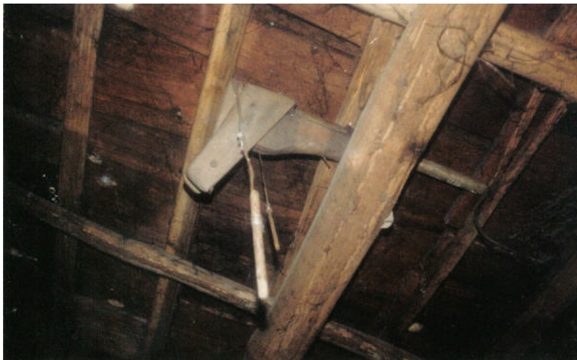
Figura 19 – Telhado de uma casa típica, feito com material da floresta, cavacos, ripas e caibros. Destaque para o bufete , arma artesanal confeccionada artesanalmente a partir de duas espécies, Cupiúba ( Goupia glabra ) e Piquiá ( Caryocar villosum Pers.), em Jericó, Garrafão do Norte, Pará. Foto: Paulo Vieira.
