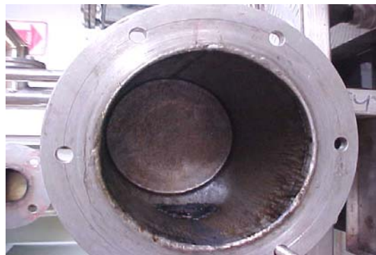
Figura 6-18 - Presença de umidade no filtro
