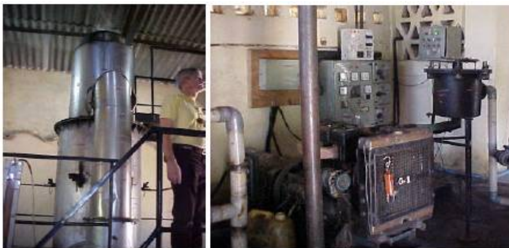
Figura 5-3 - Sistema de 20 KW(20kg/h) instalado em Hosahalli, Índia (Rocha, 2002)
