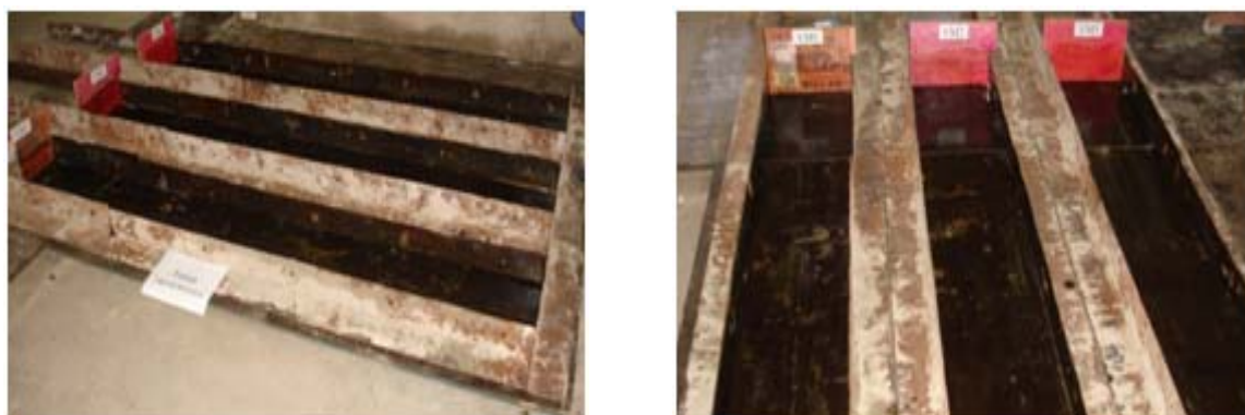
Figura 3.28 – Detalhes da forma das vigas maciças
