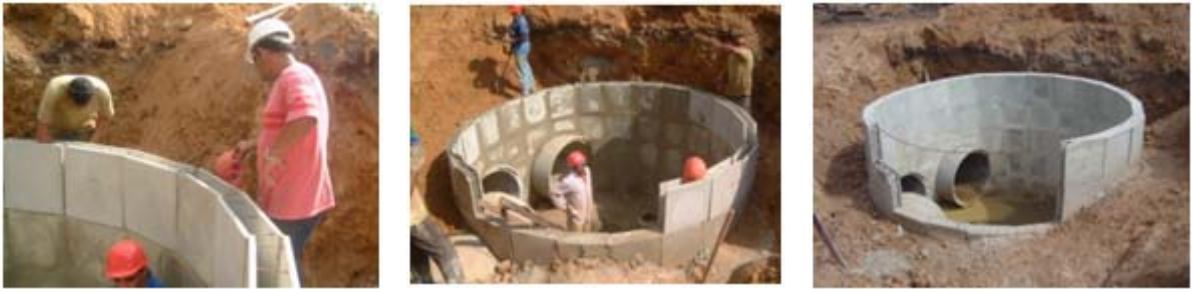
Figura 2.11 - Poço de visita em elementos pré-formados
