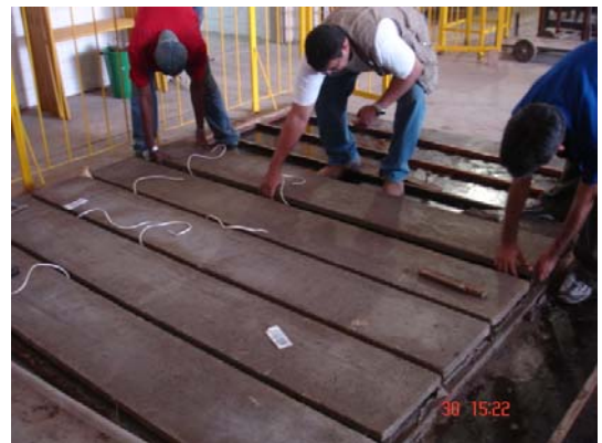
Figura 3.31 – Concretagem da segunda etapa (lateral 2)
