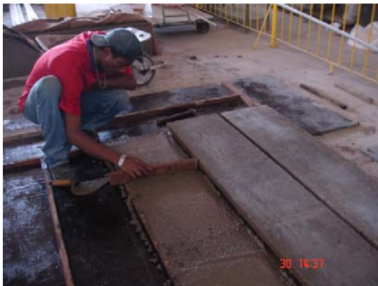
Figura 3.31 – Concretagem da segunda etapa (lateral 2)
