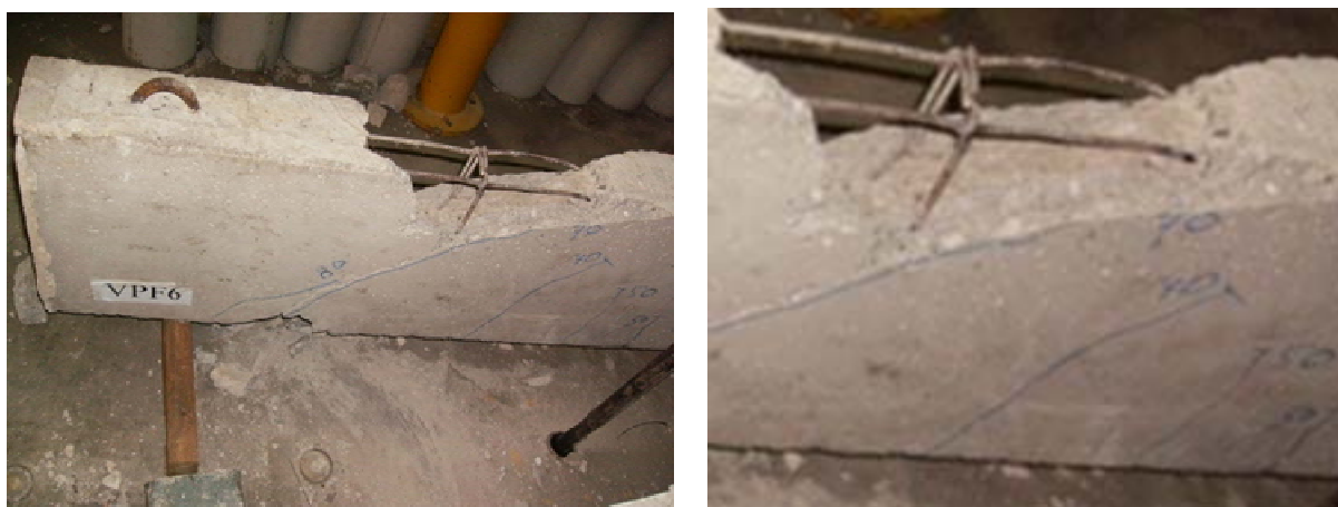
Figura 4.44 – Detalhes das camadas de concreto fissuradas na mesma seção VPF6
