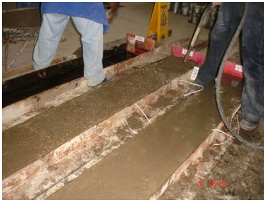
Figura 3.35 – Concretagem das vigas maciças
