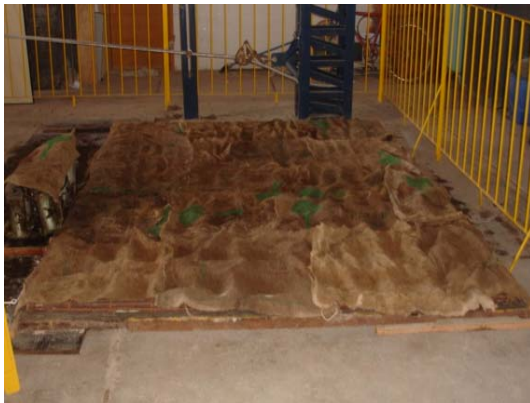
Figura 3.30 – Cura do concreto e placas desformadas da primeira etapa (lateral 1)
