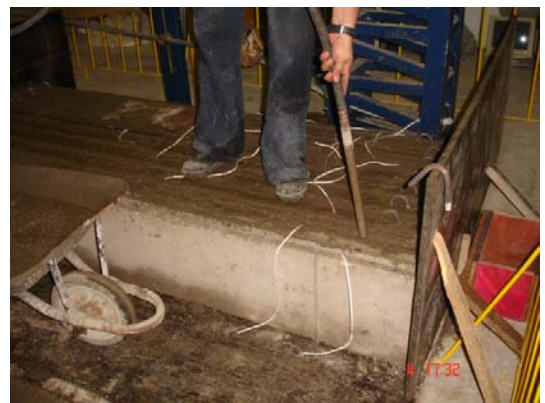
Figura 3.34 – Concretagem da quarta etapa (núcleo)
