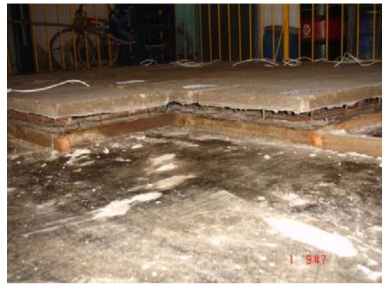
Figura 3.32 – Concretagem da segunda etapa (lateral 2)
