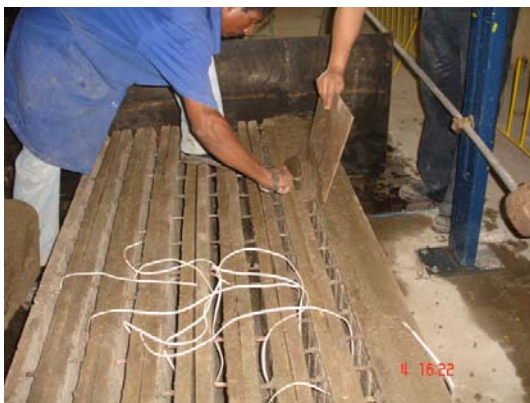
Figura 3.34 – Concretagem da quarta etapa (núcleo)
