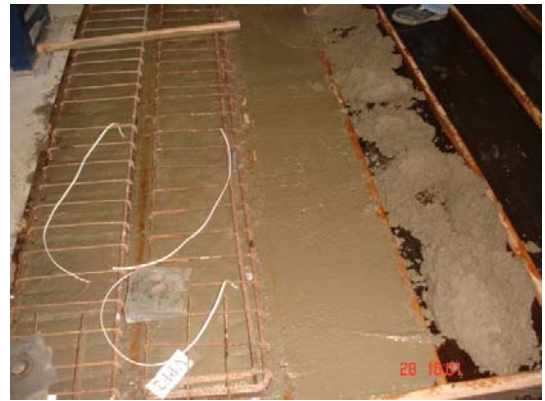
Figura 3.29 – Concretagem da primeira etapa (lateral 1)
