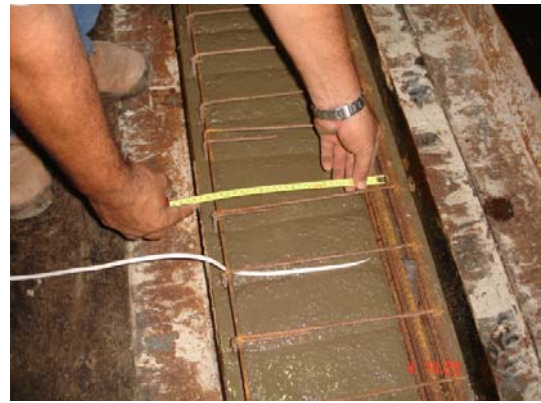
Figura 3.35 – Concretagem das vigas maciças
