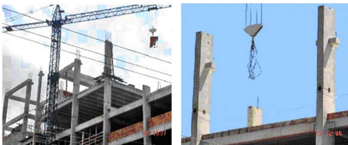
Figura 2. 1 - Equipamentos de montagem de pré-moldados (SILVA FILHO et al., 2006)
