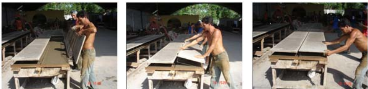
Figura 2.5 - Fabricação de elementos pré-formados
