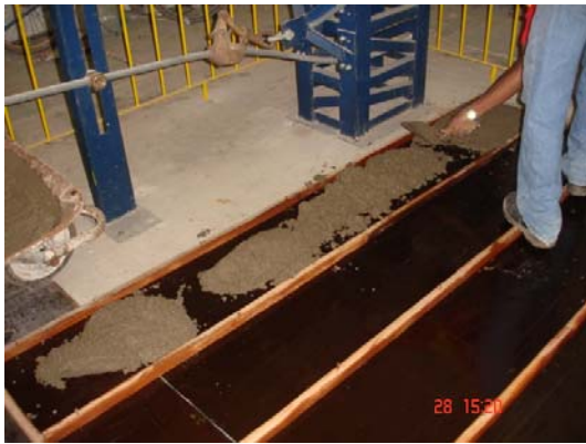
Figura 3.29 – Concretagem da primeira etapa (lateral 1)
