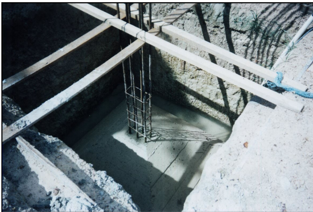
Figura 4.7 – Sapata de fundação Ed. Rio Mississipi. Belém - PA (2001)
