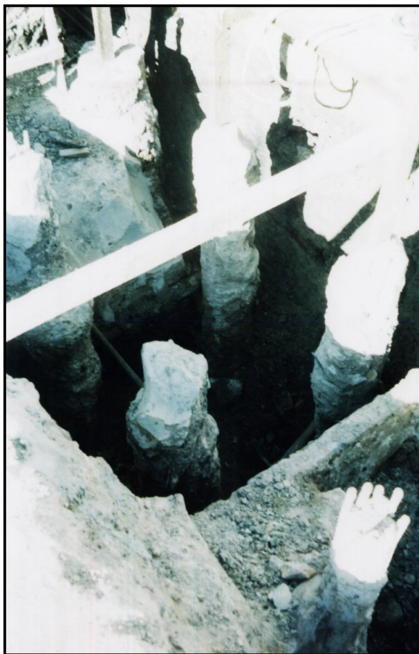
Figura 4.16 – Aspecto das estacas raiz Ed. Torre de Durhan – Rua Boaventura da Silva Belém – PA (2001)
