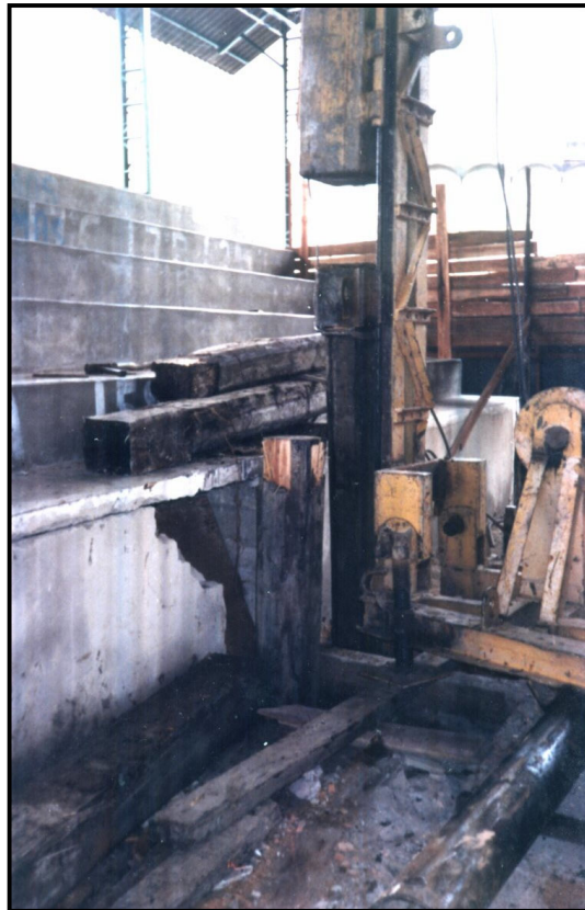
Figura 4.10 – Exemplo de cravação de estaca de madeira Fonte: Autor (1998)
