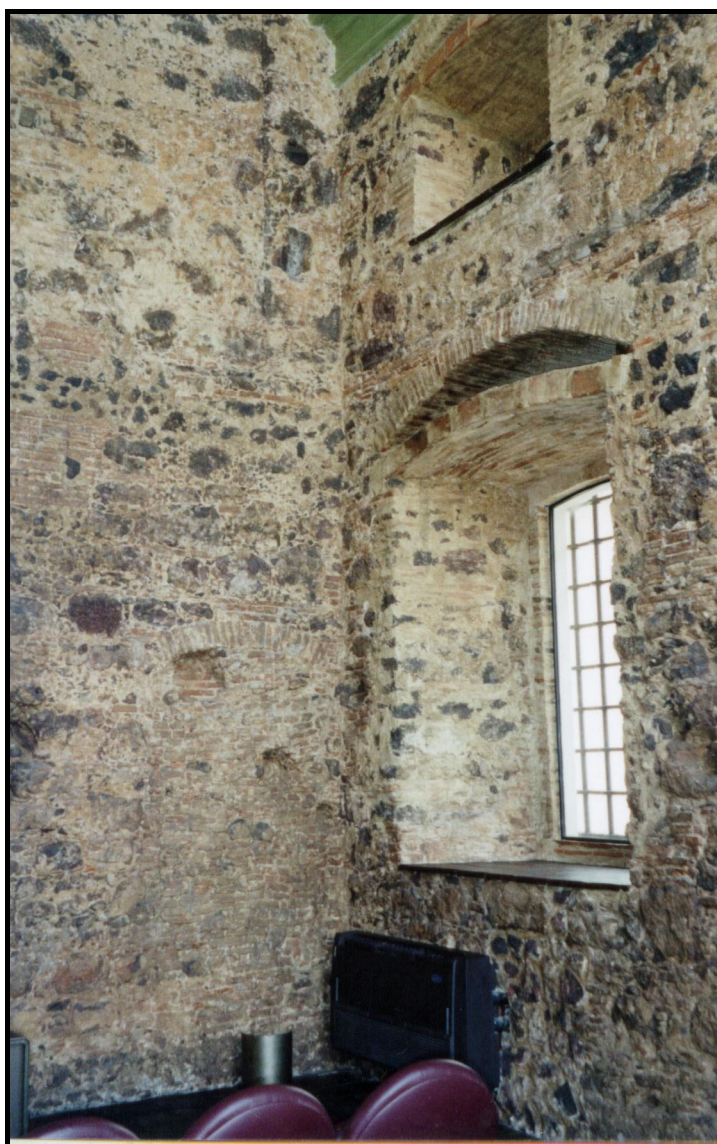
Figura – 2.8 Detalhes das paredes da Capela do Convento São José Centro Turístico São José Liberto. Cidade de Belém do Pará (2002)
