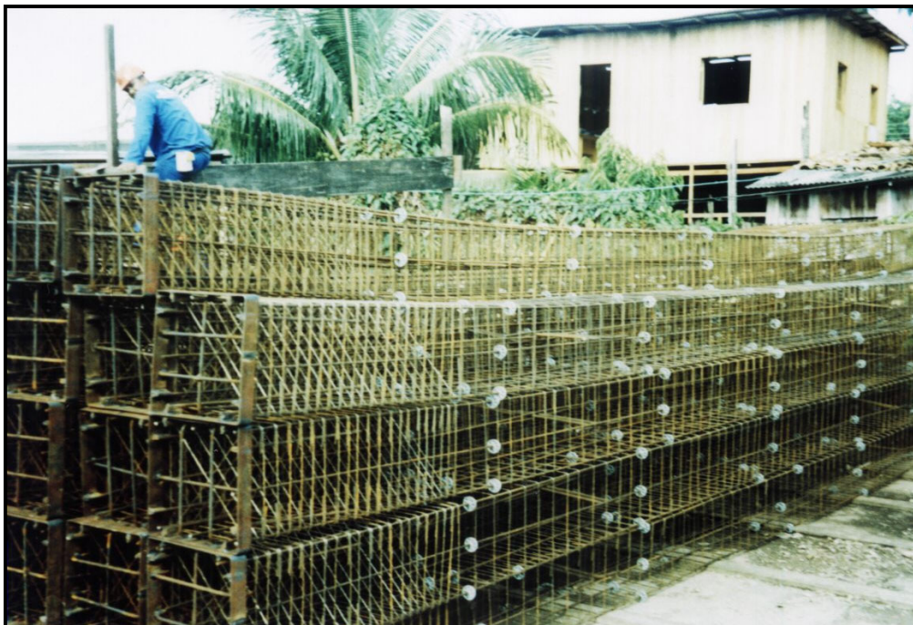
Figura 4.14 – Armaduras de estacas de concreto armado fabricadas no local Canteiro de obra do Ed. Rio Tâmis – Rua dos Mundurucus Belém - PA (2001)
