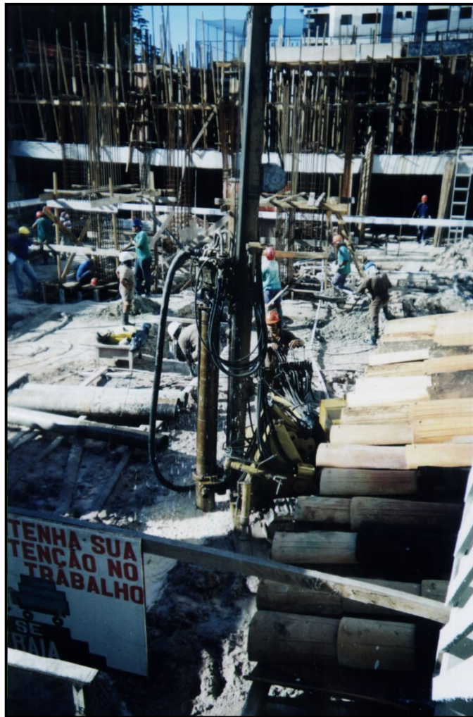
Figura 4.15 – Exemplo de execução de estaca tipo raiz Ed. Torre de Durhan – Rua Boaventura da Silva Belém – PA (2001)
