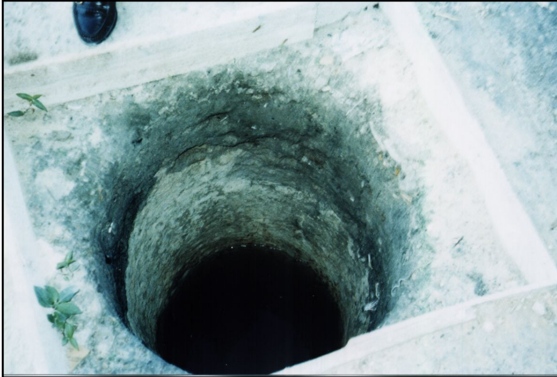
Figura 4.9 – Escavação de tubulão a céu aberto Ed. Rio Mississippi – Trav. Curuzu Belém – PA (2001)
