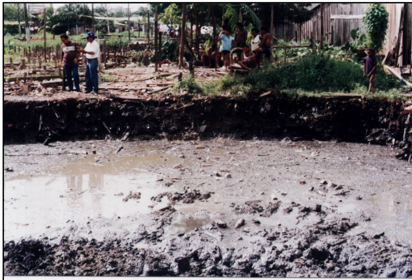
Figura 3.3-a Aspecto da formação superficial do solo de Belém nas áreas de baixada Trecho da Av. Antonio Baena Fonte: Macro drenagem da bacia do Una (2001)
