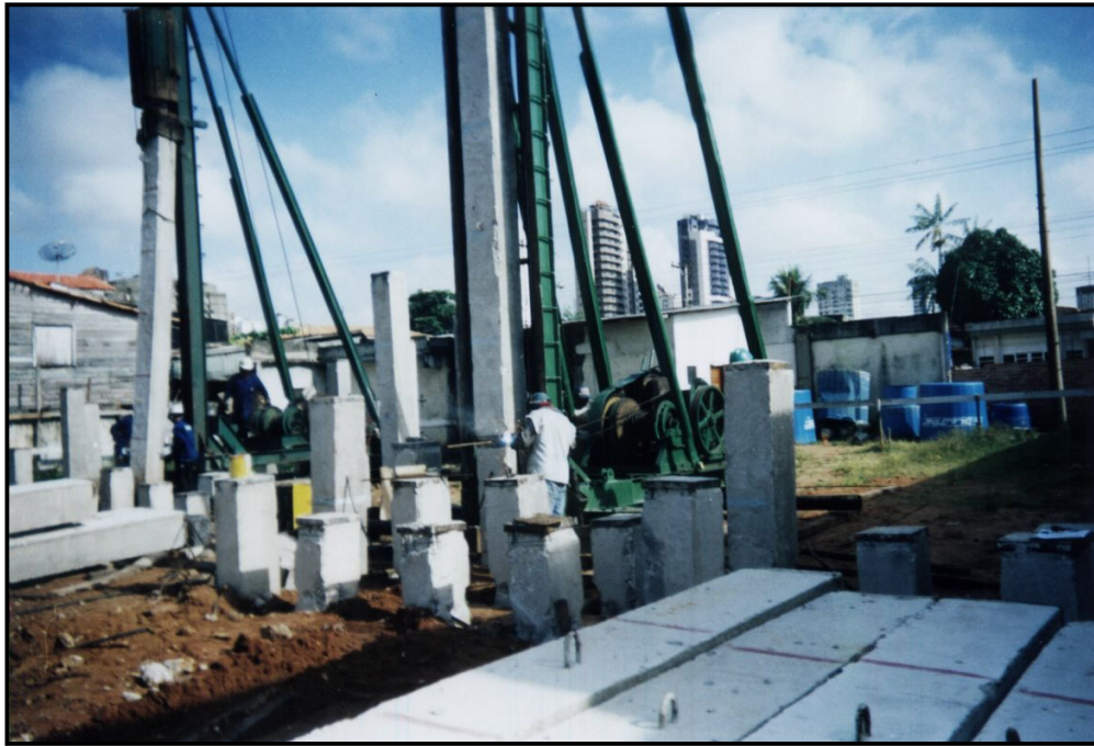
Figura 4.12 – Exemplo de cravação de estaca de concreto armado Ed. Rio Tâmis – Rua dos Mundurucus Belém - PA (2001)
