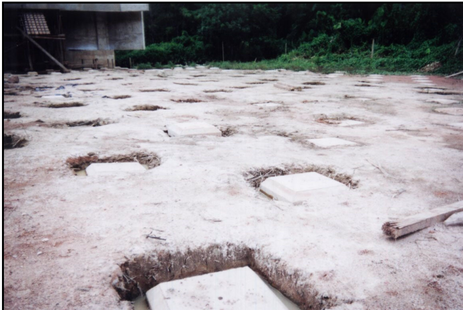
Figura 4.11 – Exemplo de agulhamento com capitéis na Alça Viária de Belém Belém – PA (2001)
